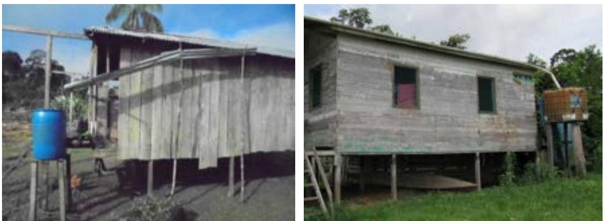
Figura 49: Sistemas de captação de água de chuva e reservatórios de armazenamento.
