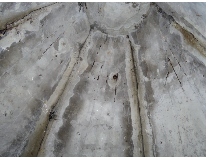
Bild 7: Blick in das Innere des gleichen Kleinbunkers (Foto: D. Hopp)
