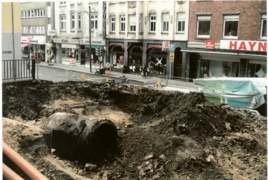
Bild 14: Einmannbunker am Mineralienmuseum während der Bauarbeiten 2000/2001 (Foto: R. Busch)
