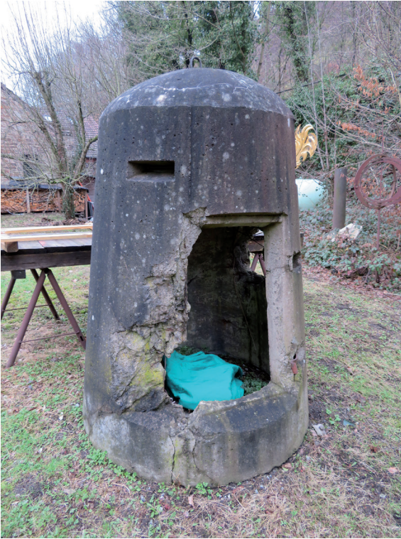
Bild 11: Die Splitterschutzzelle am Kupferhammer (Foto: D. Hopp)
