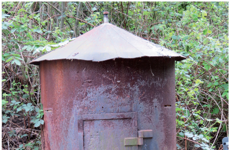
Bild 16: Extrem klein sind die Schlitze rechts und links neben der Tür in der Wandung des Kleinbunkers (Foto: B. Janzigaj)
