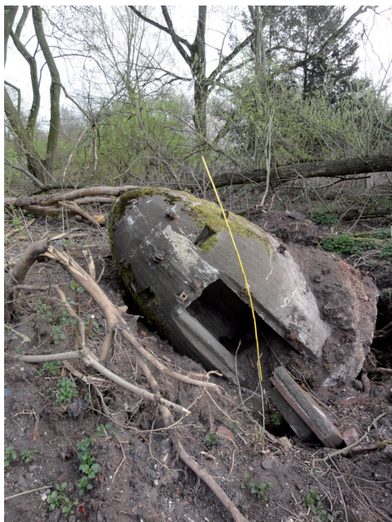
Bild 1: Aus dem Boden herausgerissener Bunker 2017 (Foto: D. Hopp)
