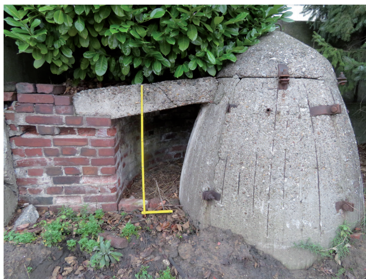
Bild 5: Die Splitterschutzzelle an der Köndgenstraße (Foto: D. Hopp)
