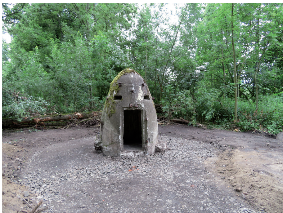
Bild 2: Der Bunker nach seiner Wiederaufrichtung 2017, noch ohne Tür (Foto: D. Hopp)
