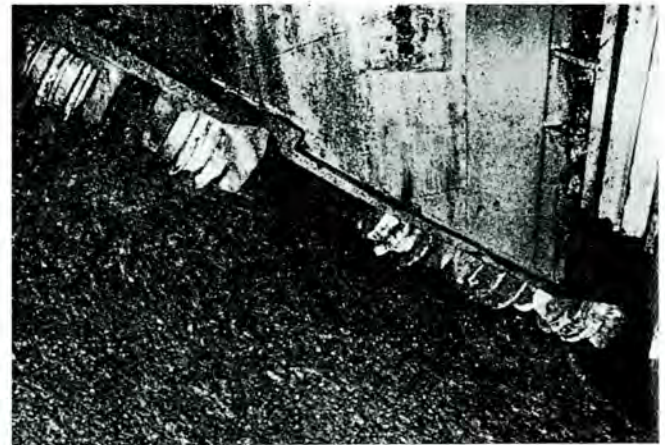
Bild 3. Die Verschmutzung der Bohrwerkzeuge und der Bohrlochsohle, rechts das Vorbohrloch.
