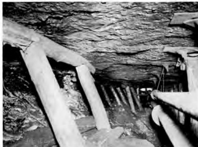
Bild 8. Schrägstellung der an Stelle von Holzkästen im Unterstoß der Anker-Türstock-Strecke Nr. 2 eingebrachten Brechholzreihen. Der im Flözliegenden befindliche Streckenstoß ist in die Strecke hineingeschoben worden (im Photo nach rechts).
