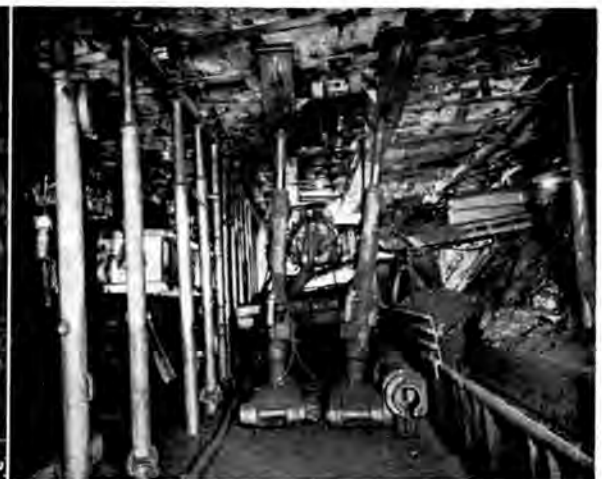
Bild 7. Der Übergang Streb-Strecke beim Anker-Türstock-Ausbau im Flöz Ernestine 1 W. Blick aus dem vorgesetzten Streckenteil auf die Einschienehängbahn (links) und die hydraulische Schreit-Spannstation mit Kappenschreitwerk und hydraulischem Vorziehgerät für den Kettenkratzerförderer; Strebförderer mit Kohlseitenaustrag.
