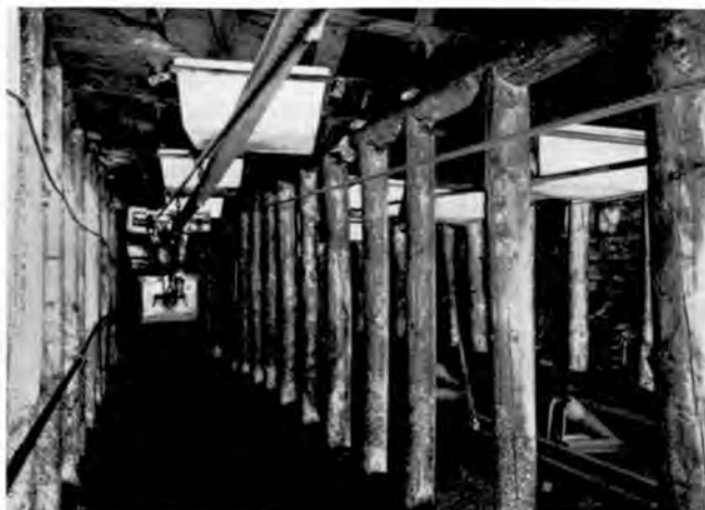
Bild 13. Fußstrecke mit Anker-Türstock-Ausbau in Flöz Ernestine rd. 200 m nach Strebdurchgang.
