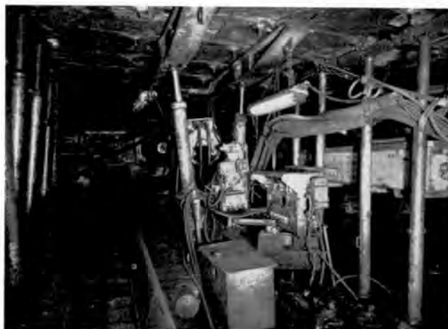
Bild 15. Übergang Streb-Strecke in der Anker-Türstock-Strecke in Flöz Ernestine. Blick in Richtung vorgesezten Streckenort auf hydraulische Schreit-Spannstation mit zentralem Steuerstand für Strebförderer und Kohlenhobel.
