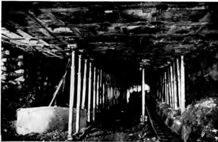
Bild 5. Anker-Türstock-Ausbau in der Fußstrecke im Flöz Ernestine 1 W. Blick von der Ortsbrust zum Übergang Streb-Strecke mit hydraulischer Schreit-Spannstation im Hintergrund. Rechts im Bild der mit Holzankern verfestigte Kohlenstoß, links das Transporttrum mit Einschienehängbahn-Abspannung und Schutzschild gegen beim Sprengen herausgeschleudertes Haufwerk.
