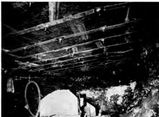
Bild 7. Mit vollverklebten Ankern, Flacheisen als Querverbindung und Verzugsblechen gesicherte Streckenfirste in Flöz Karl.
