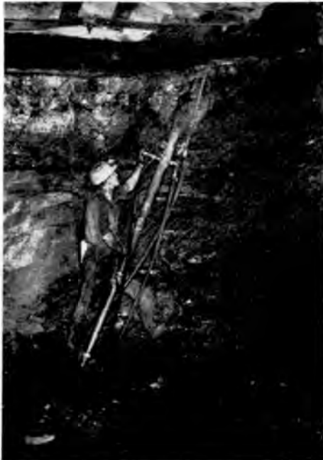
Bild 1. Die Dreifachteleskop-Bohrstütze A 1100 beim Bohren von Ankerlöchern.
