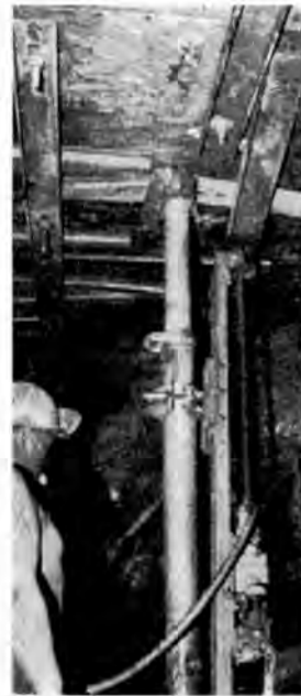
Abb. 3. Bohren eines Ankerlochs mit der Drehbohrmaschine P II/2.
