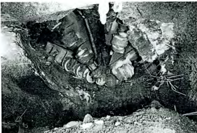
Bild 1. Der für das Blindschachtbohren auf der Zeche Zollverein im Zentrum mit drei versetzt angeordneten, axial verzahnten Schneidrollen bestückte Bohrkopf der Gesenkbohrmaschine GSB-450/500.
