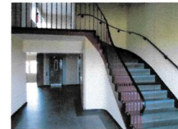
Einzelstiege zur Erschließung des obersten Geschosses im Einraumflügel, bauzeitliche Gestaltung
