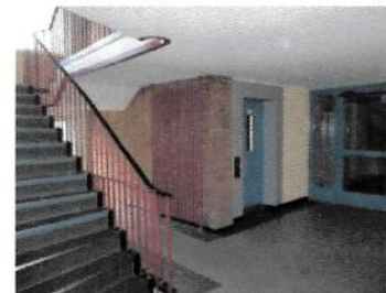
Zentrales Treppenhaus mit Sichtbacksteinwänden und Heizelementen, Treppengeländer und Fahrstuhltür bauzeitlich
