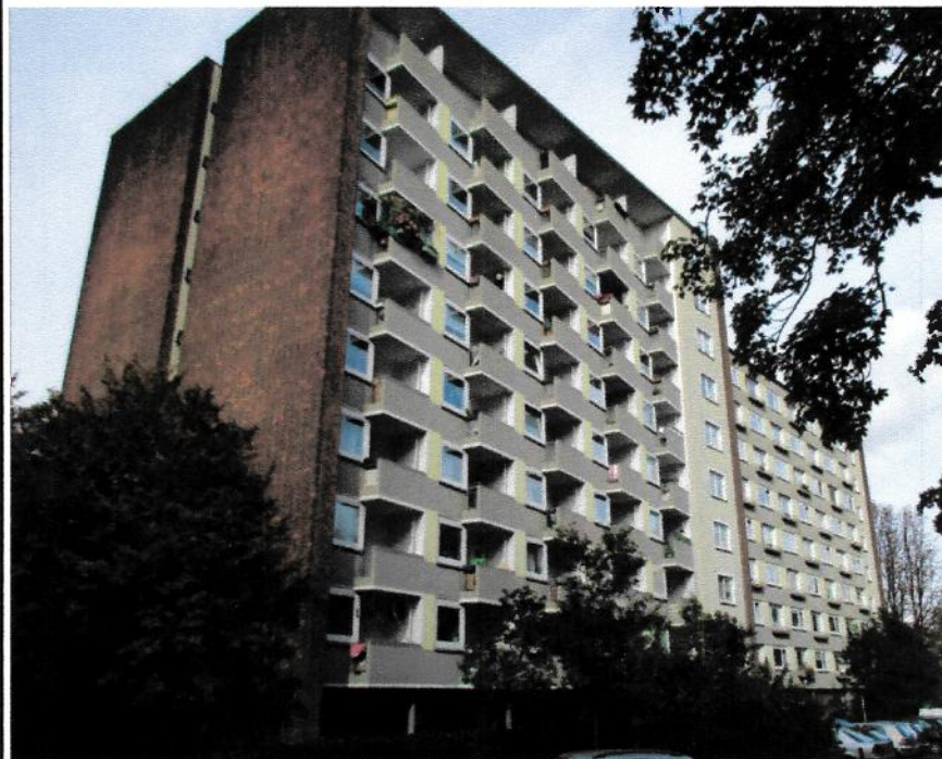
Ansicht von Südwesten, 2016 (Foto: Sven Kuhrau)
