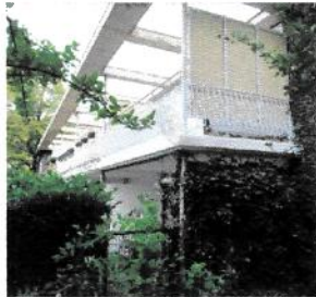
Wohn- und Ladenzeile, Wohngeschoss mit Luftbalken und bauzeitlichem Geländer
