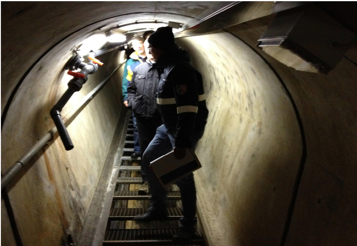
Abbildung: Entlastung im rechten Hang ohne Manometeranschluss
