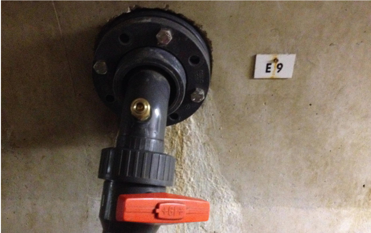
Abbildung: E9 mit Manometeranschluss
