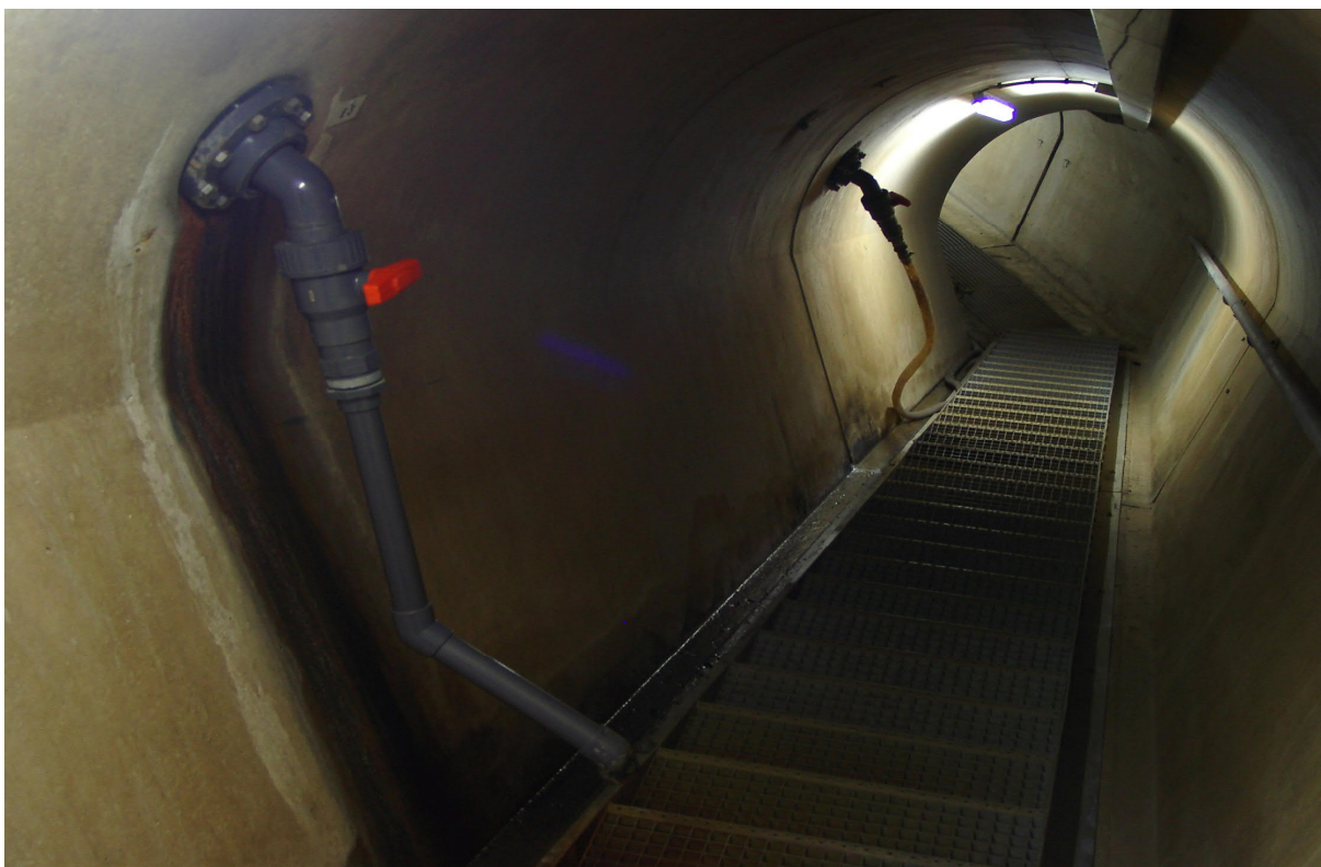
Abbildung: Herdmauer – Kontrollgang mit Entspannungen (geschlossen)
