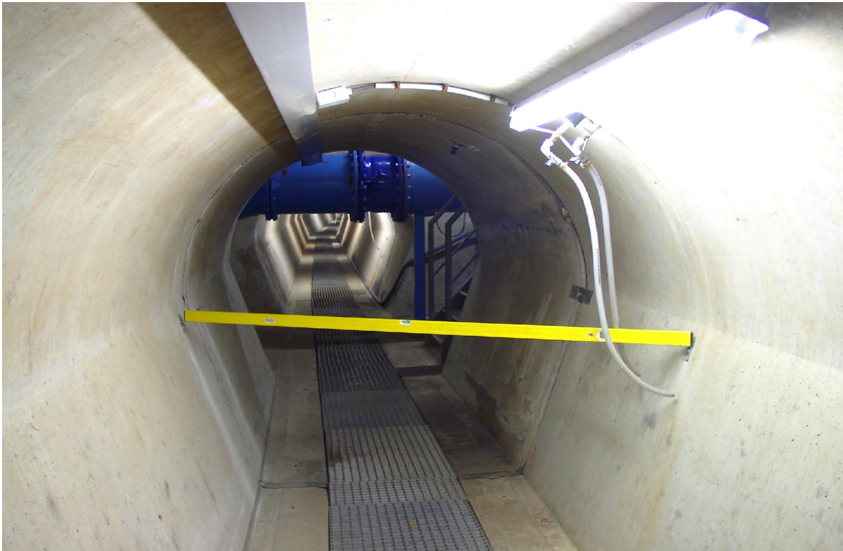
Abbildung: Verformungskontrolle in der Herdmauer mittels Messmarken und Wasserwaage
