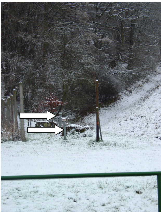
Abbildung: Brunnen GB 2L und GB2 am luftseitigen Dammfuß
