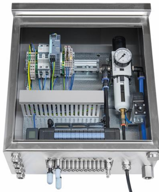
Hygienic-Design-Schaltschrank für den Einsatz im hygiesensiblen Umfeld. (Foto: Bürkert Fluid Control Systems)
