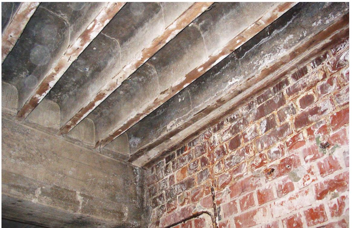
Beispiel: Stahlbetonrippendecke (Koenen'sche Decke)
