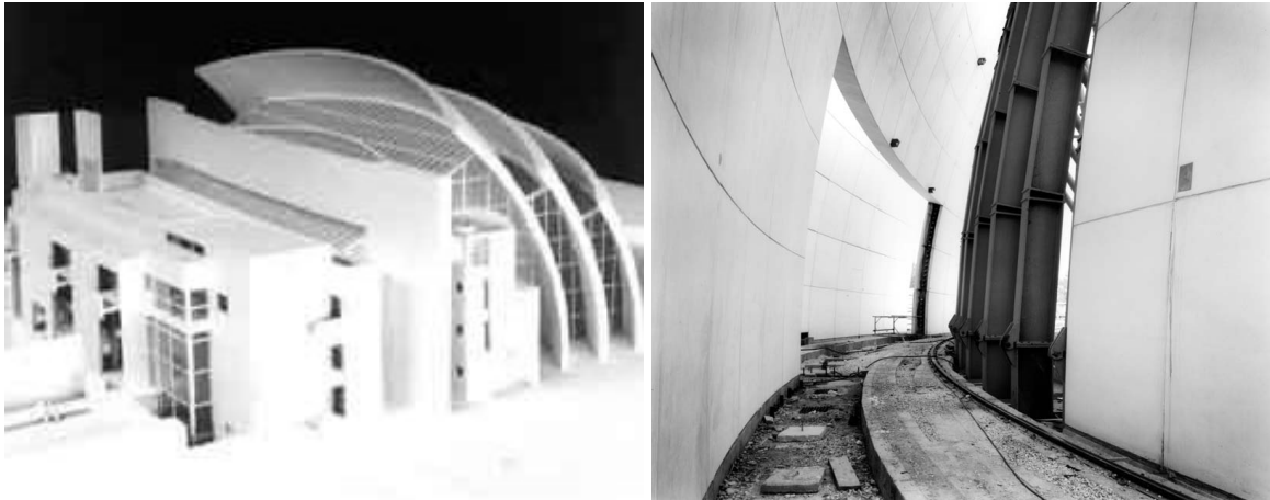
Abb. 8: Modell (links) und Photographie (rechts) der im Bau befindlichen „Dives in Misericordia-Kirche“ in Rom, welche aus \text{TiO}_2 -modifizierten Zement gebaut wird [Italcementi 2002a; Italcementi 2002b].
