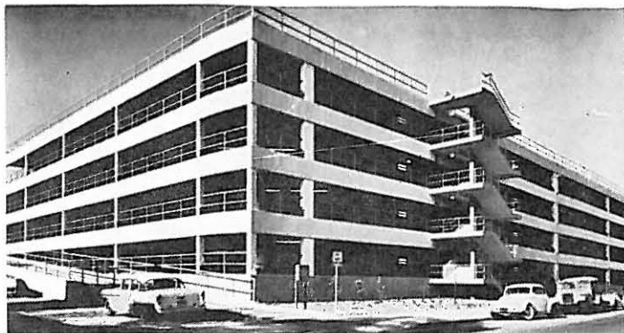
Bild 4 Parkhochhaus in San José, Californien, aus Leichtbeton der Güte B 410 mit Drehofenblähton. Balken und Unterzüge sind vorgefertigt und vorgespannt; Decken, Säulen und Randträger in Ortbeton [21]
