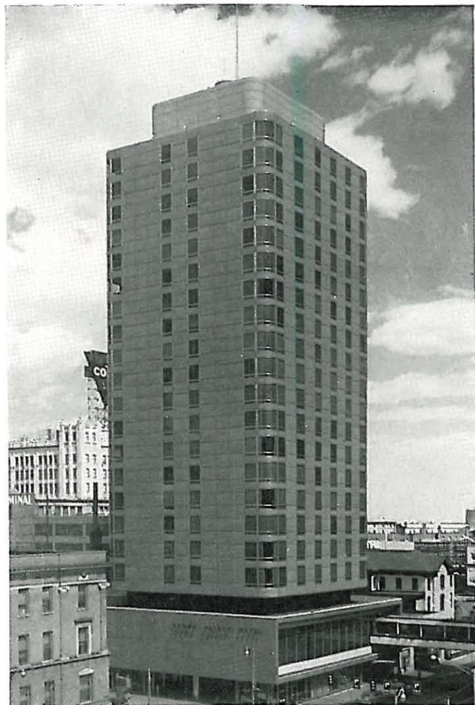
Bild 3 Brown Palace Hotel in Denver, Colorado. Die gesamte tragende Konstruktion ist aus Leichtbeton, Stützen in B 410, Decken in B 310; die Rohddichte betrug nur 1,54 \text{ kg/dm}^3 [20]
