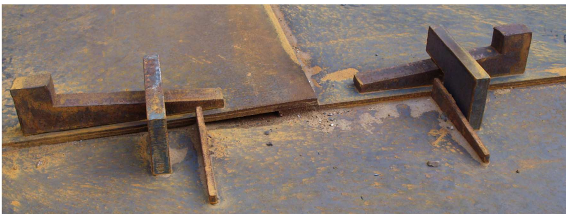
Abbildung 15: Fixierung der Bodenbleche
