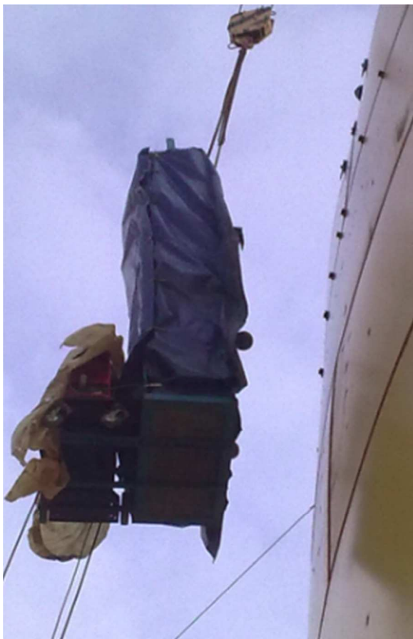
Abbildung 13: Einhängen eines zweiteiligen Schweißerkorbes mit Plane
