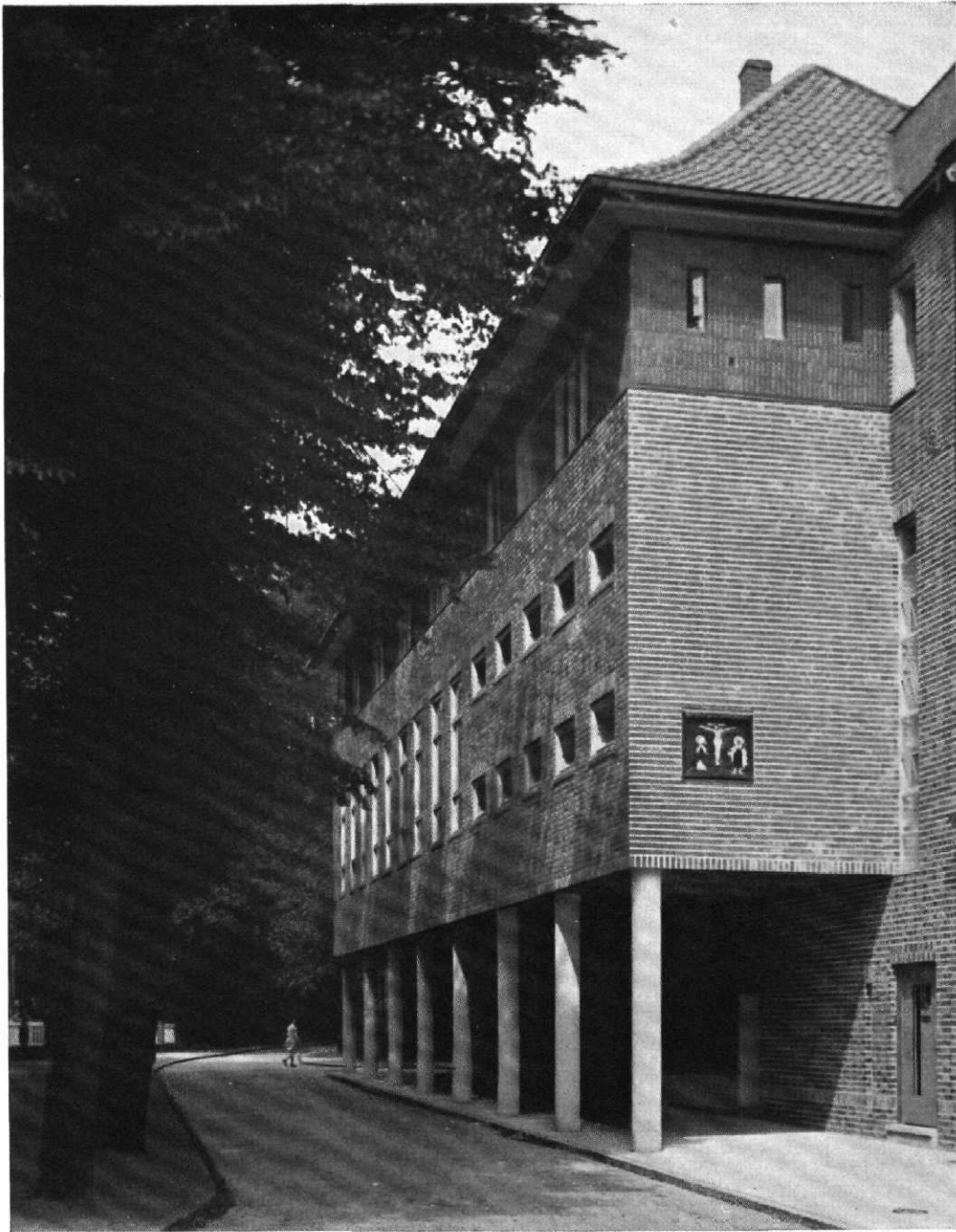
Abb. 1 / St. Petri- und Pauli-Gemeindehaus in Bergedorf / Architekt: Hermann Distel, Hamburg / Ansicht vom Kirchplatz
