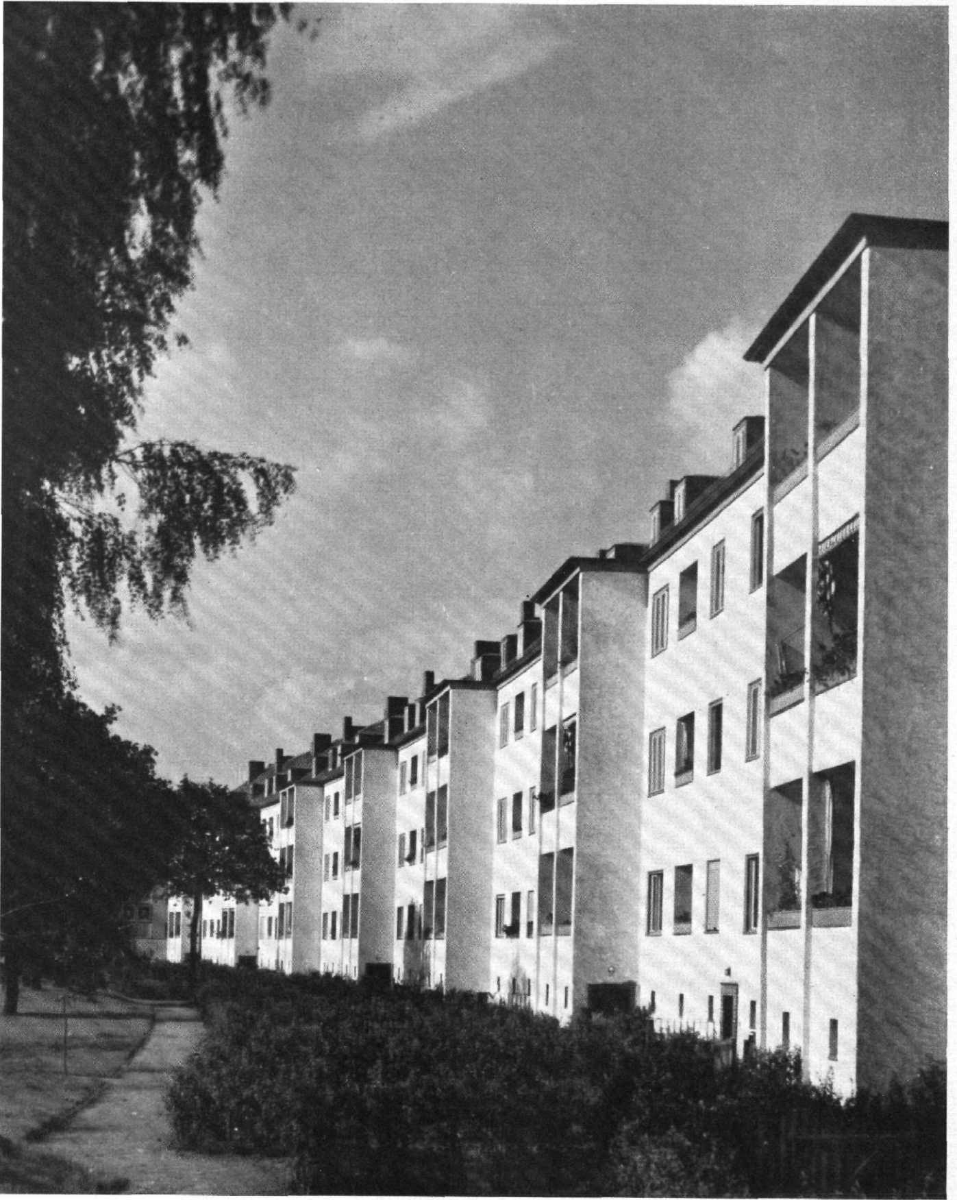
Abb. 5 / Siedlung „Heimat“ in Siemensstadt / Architekt: Hans Hertlein, Berlin Die Loggien im Block P vom Standpunkt 3 gesehen
