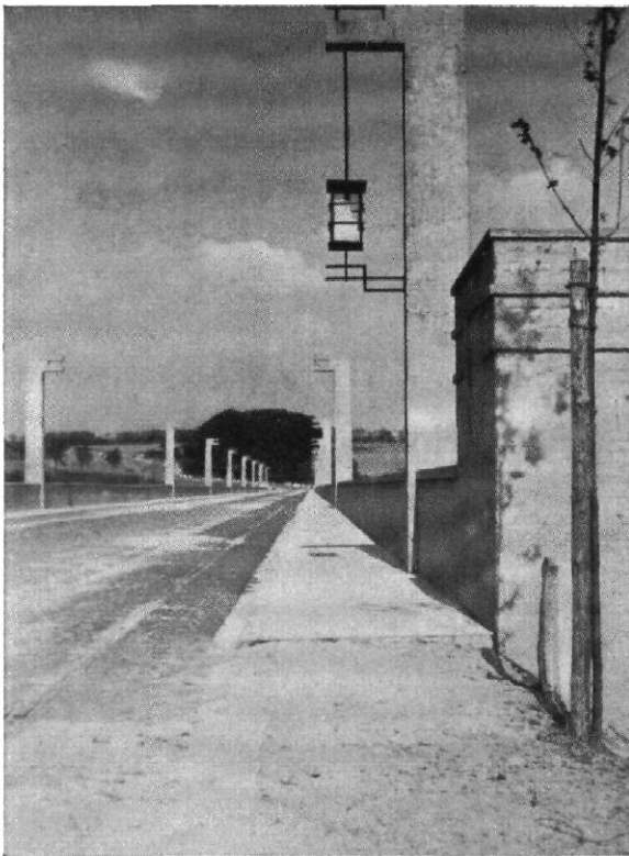
Entwurf zur Brücke über die Rance, Nordfrankreich Konstruktion: Christoph und Unmack, Niesky / Architekt: Konrad Wachsmann, Berlin Die Brücke ist eine Straßenbrücke und hat eine Länge von 1,2 km. Die Fahrbahn ist 12 m breit, die Eisenkonstruktion 14 m hoch, die Betonpfeiler, die im Abstand von 250 m stehen, haben eine Höhe von 60 m.
