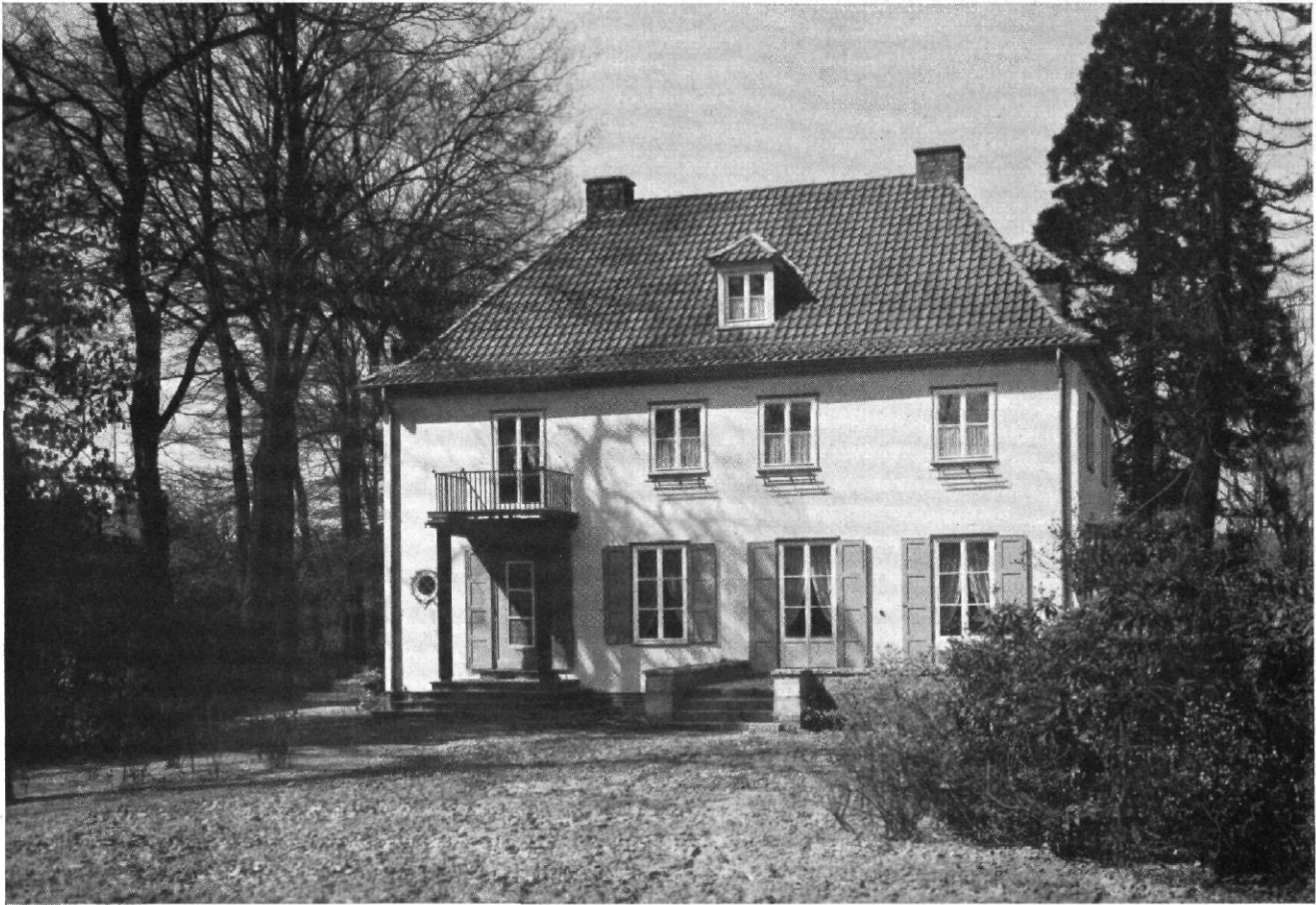
Abb. 1 / Wohnhaus Schütte in Bremen / Architekt: Otto Blendermann, Bremen / Eingangseite
