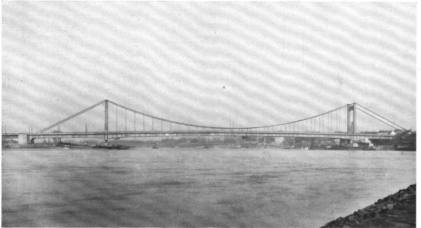
Abb. 1 / Die neue Köln—Mülheimer Rheinbrücke / Architekt: Adolf Abel, München / Gesamtansicht der Brücke stromabwärts
