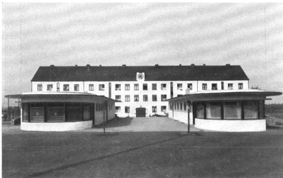
Abb. 2 / Siedlung in Dortmund-Eving Architekten: Pinno und Grund, Dortmund
