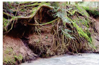
Durch den Bach freigespülte Wurzeln
