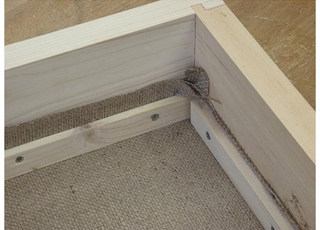
Die Isolierzarge füllt man mit Hobelspänen, gehäckseltem Stroh oder anderem feuchtigkeitsabsorbierenden Material. Heu ist nicht geeignet, da es leicht schimmelt.
