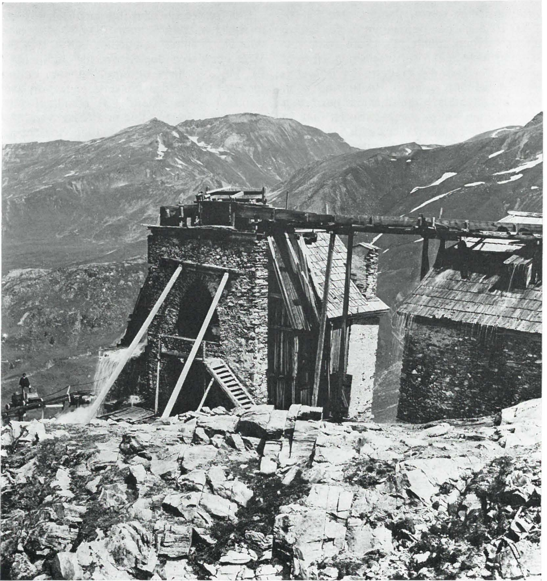
Abb. 7: Das Radhaus des Schrägaufzuges auf den Hohen Goldberg in Rauris. Um 1885.
