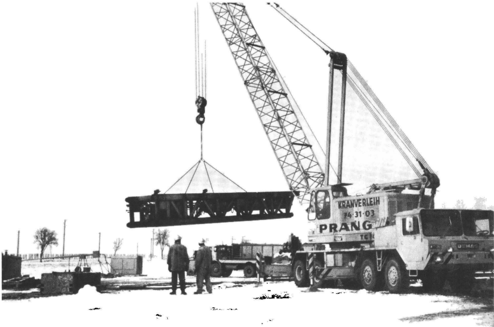
Abb. 65. Bohranlagenaufbau mittels Mobilkran
