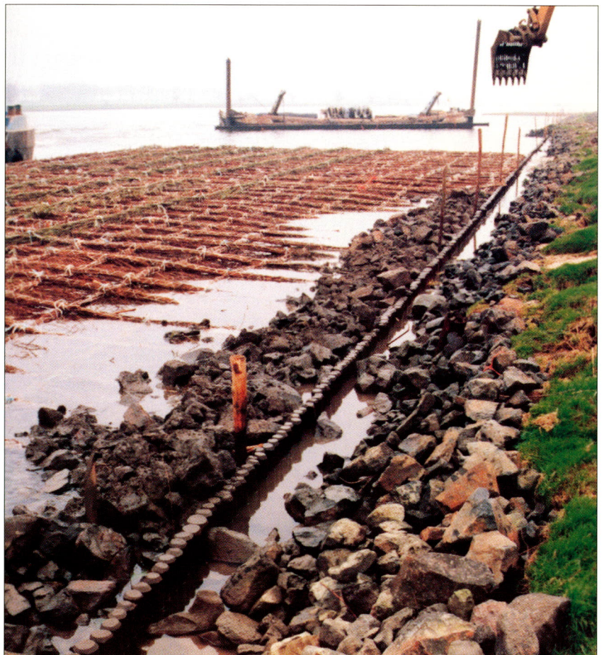
foto 34: Het kraagstuk is in positie gebracht langs de oever tegen de perkoenpalenrij en met palen verankerd.
