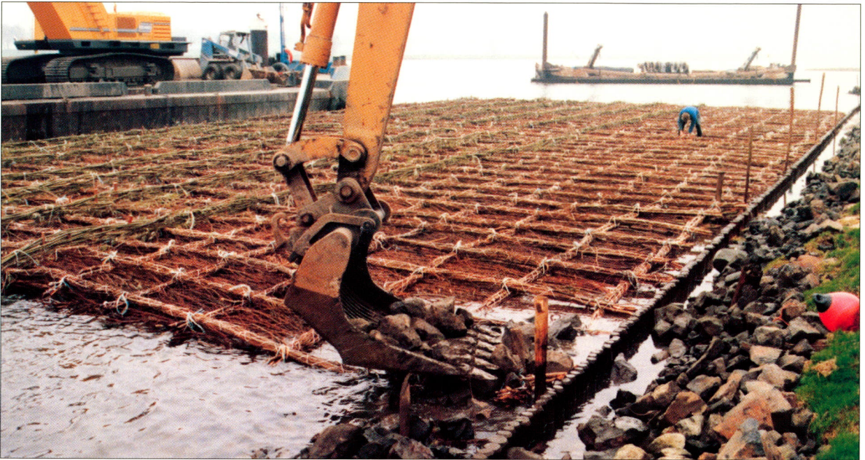
foto 34: Het kraagstuk is in positie gebracht langs de oever tegen de perkoenpalenrij en met palen verankerd.
