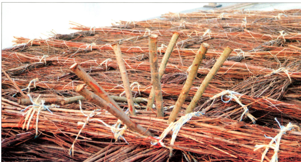
foto 33: Voorbeeld van een prop voor het bevestigen van sleep- en ankerrossen.
