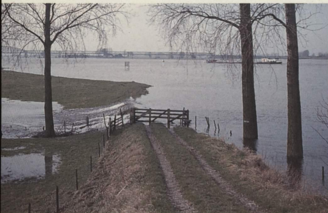
Im Winter und im Frühling tritt der Rhein häufig über sein Sommerbett. In diesen Jahreszeiten stehen die Überschwemmungsräume meistens unter Wasser.
