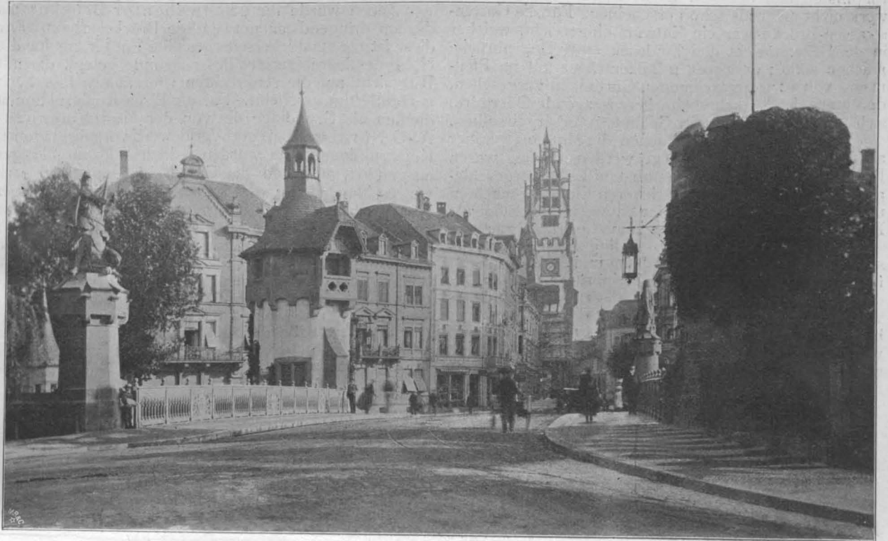
Abbildg. 1. Die Schwabentor-Brücke in Freiburg i. Br.
