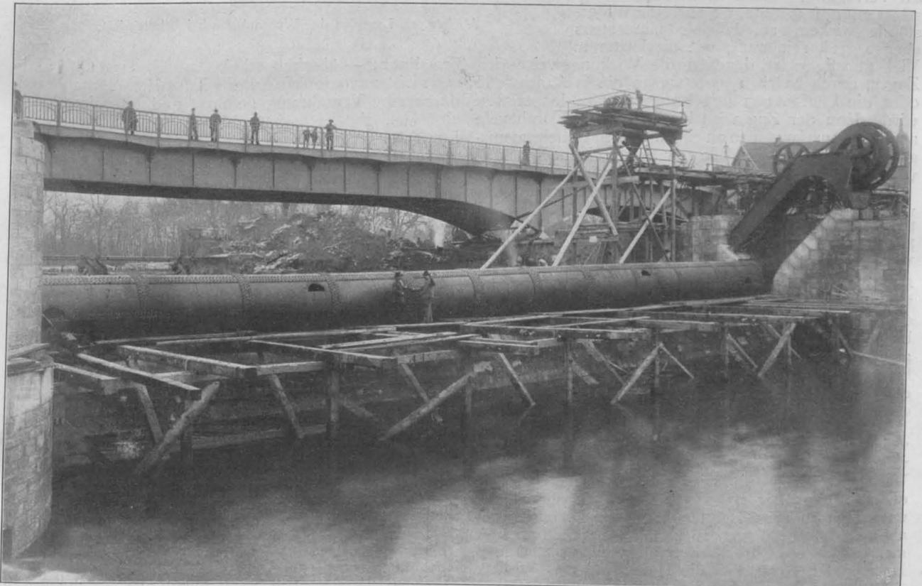
Abbildg. 1. Walzenverschluß des 35 m weiten Ueberfallwehres im Hauptarm des Mains. (Walze in niedrigster Stellung.)
