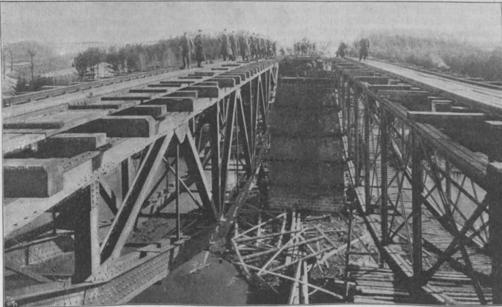
Abbildg. 4. Alter Ueberbau seitlich herausgeschoben, neuer Ueberbau während der Ueberschiebung auf die Pfeiler. Die Auswechslung des eisernen Ueberbaues der Walschbrücke bei Königsberg i. Pr.
