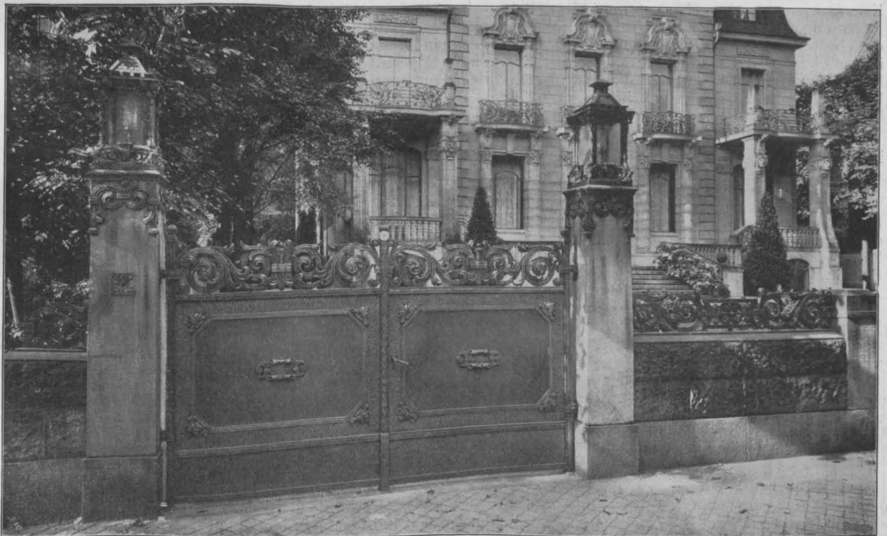
Tor und Umwehrung. Haus Hagen in Cöln am Rhein. Architekt: Regierungs-Baumeister a. D. Eugen Fabricius in Cöln a. Rh.
