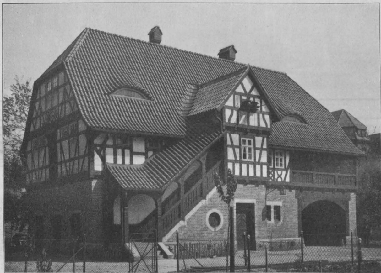
Kreishaus in Zabrze. Stallgebäude, Ansicht von Südwest.
