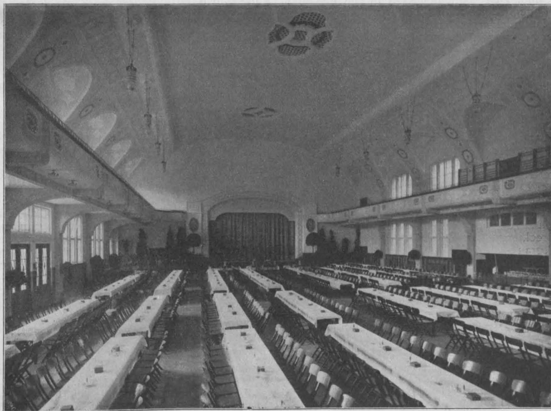
Die Turnhalle als Festsaal. Architekten: Gebr. Rank in München.
