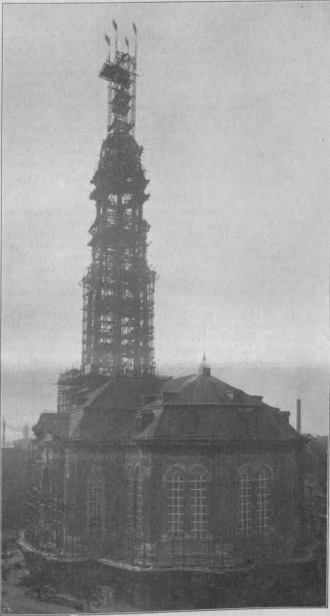
Abbildungen 12 und 13. Aufstellung der Eisenkonstruktion des Turmes in verschiedenen Stadien. (Nach photographischen Aufnahmen von Otto Reich in Hamburg.) Wiederaufbau des Turmes der St. Michaeliskirche in Hamburg.
