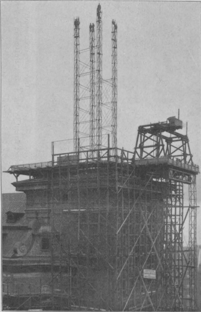
Abbildung 10. Materialaufzug zur Höhe des massiven Sockels und Aufrichtung der Montagerüstung.
