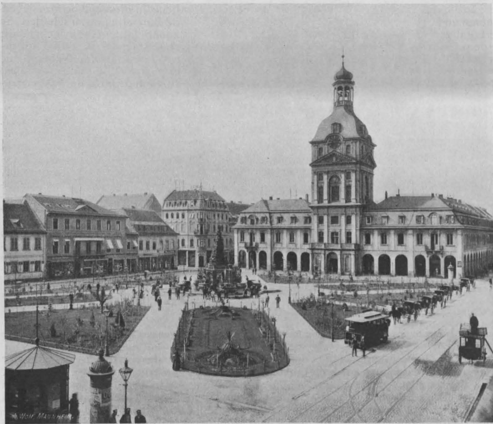
Das Kaufhaus in Mannheim und sein Umbau zum Rathaus. Zustand Ende des 19. Jahrhunderts.
