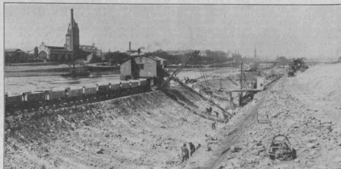
Abbildung 6 (oben). Neue Häusergruppen an der Hanauer Landstraße. Abbildung 5. Neuer Ostpark. Abbildung 7. Aushub des Flußhafens mit Schwimmbaggern. Abbildung 8. Ausschachtung für die Kaimauern am Flußhafen mit Trockenbaggern Der neue Osthafen in Frankfurt a. M.
