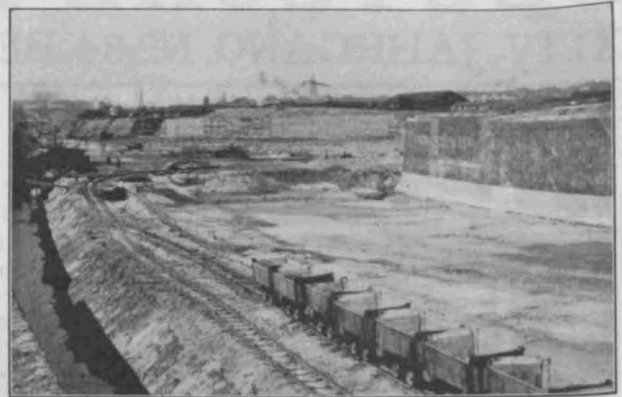
Abbildung 9. Blick in die Hafenbecken während der Herstellung.
