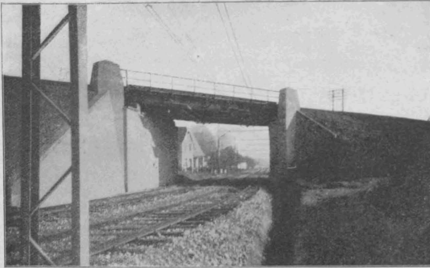
Abb. 11. Unterführung der Kleinbahn unter der Hauptbahn Köln—Frankfurt a. M.
