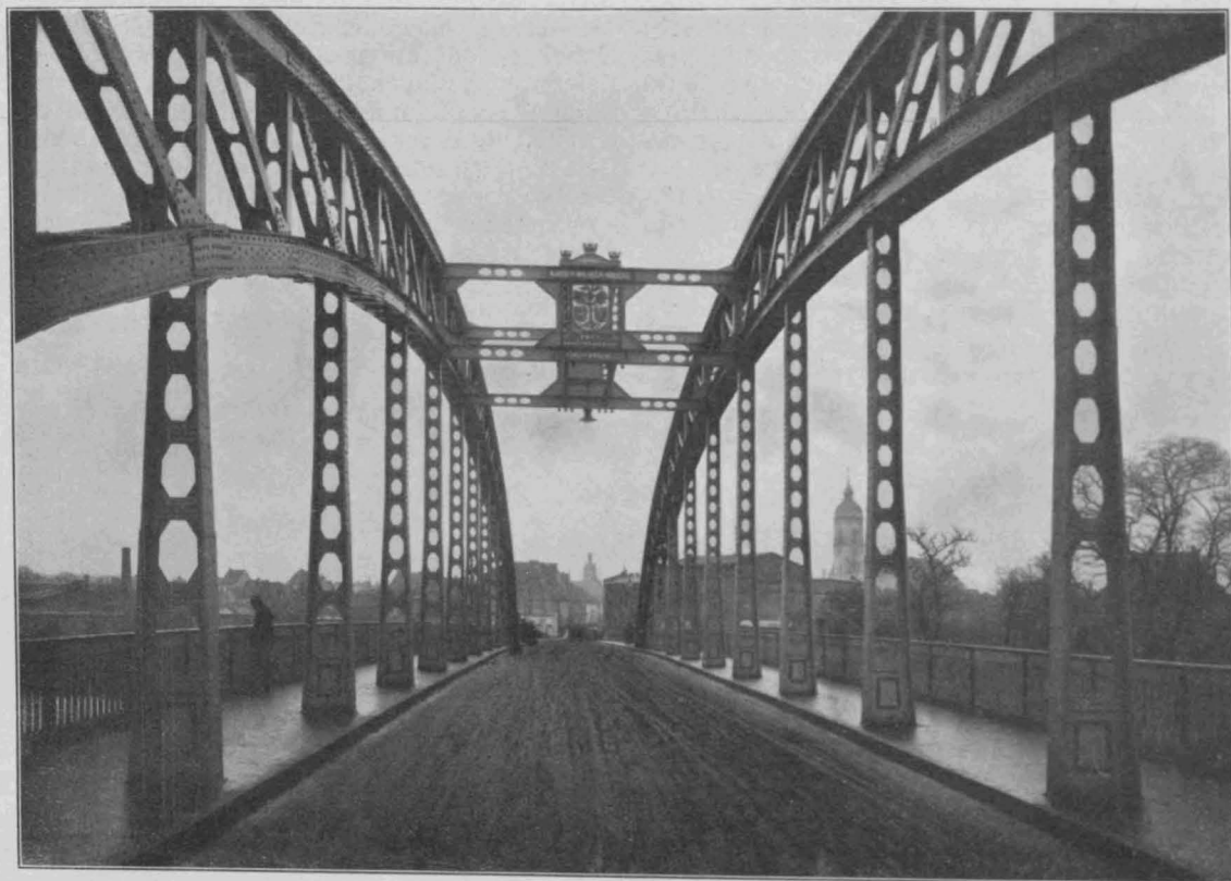
Abbildung 9. Blick in die eiserne Ueberbrückung der Schiffsöffnungsöffnung.
