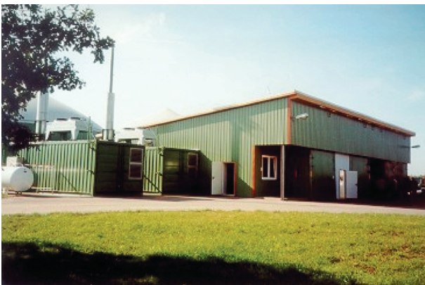
Abb. 3.12: Trockenfermentationsanlage in der Agrargenossenschaft Pirow (Land Brandenburg)
