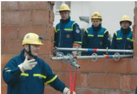
THW-Ausbilder Otto Hippler demonstrierte den Einsatz eines Delta-Auslegers.
