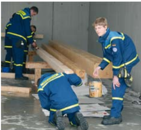
Vor dem Einbau wurden die Dachsparren grundiert.
