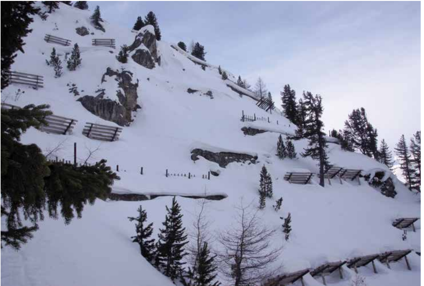
Lawinverbauungen im Gebiet Muot zum Schutz der UNESCO Albulabahnlinie und der Albulastrasse.
