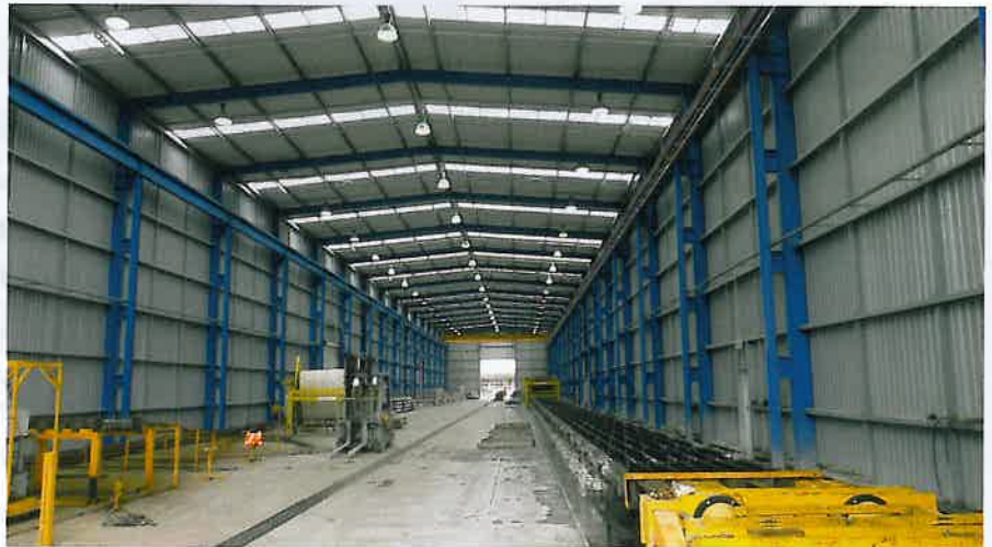
Abb. 1: Bahnschwellenproduktion auf dem Stand der Technik
