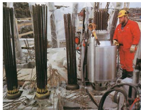
Abb. 20: Spannpresse TENSA M 9 750 kN bei Ankervor- spannung (37 x 0,6")
