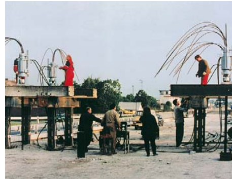
Abb. 16: Spannpresse TENSA M 3 000 kN bei Autobahn- sanierung, Anheben von Teilstücken zum Aus- bessern der Auflager
