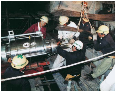
Abb. 17: Spannpresse TENSA M 9 750 kN (37 x 0,6") im Einsatz in Japan
