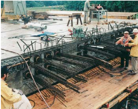
Abb. 15: Spannpresse TENSA M 3 000 kN und Eindraht- spannpresse TENSA SM 240 kN
