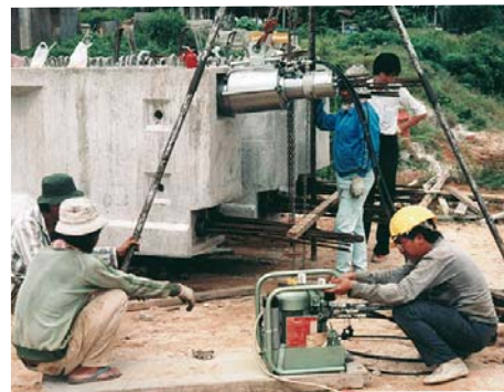
Abb. 18: Spannpresse TENSA M 1 700 kN und Kleinpum- penaggregat, Nachspann- träger auf Baustelle in Malaysia
