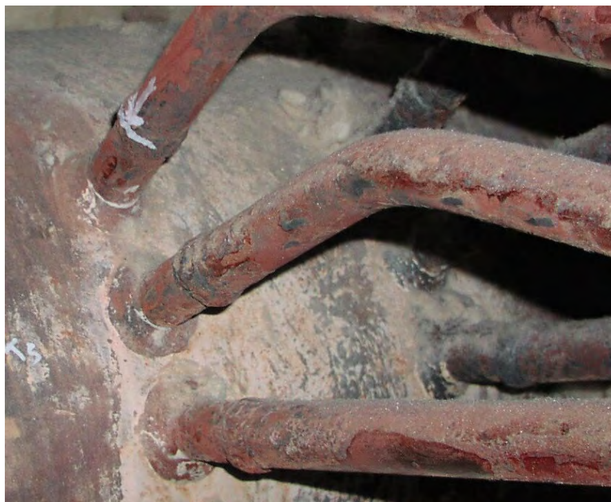
Abbildung 3-13: Fotografie von geschweißten Sammlernippeln (je 24 mm Durchm.)
