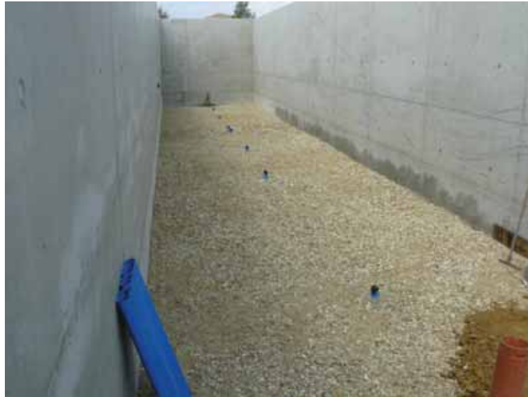
Abb. 3.28: In das Versuchsbecken eingebauter Grundwasserleiter.
