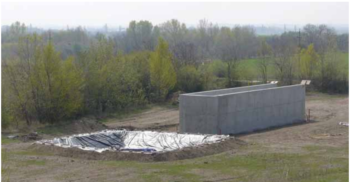
Abb. 3.4: Versuchsanlage – vorne das Wasserbecken und im hinteren Bereich die Stahlbetonkonstruktion des Versuchsbeckens
