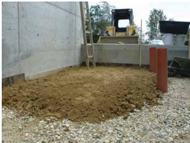
Abb. 3.29: Erste Ausgleichslage des geschütteten Deckschichtmaterial auf dem Grundwasserleiter.
