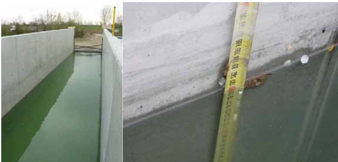
Abb. 3.5: Dichtigkeitsprüfung zur Kontrolle allfälliger Wasserverluste des Versuchsbeckens – Messpegel zur Beobachtung der Wasserstandsänderungen im Versuchsbecken
