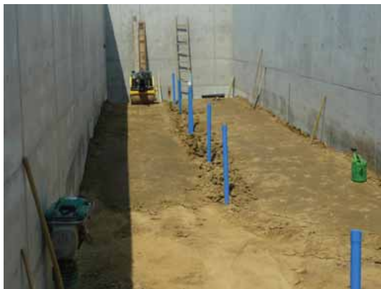
Abb. 3.34: Bindige Deckschicht mit den bis zum Beckenboden reichenden Pegelrohren.
