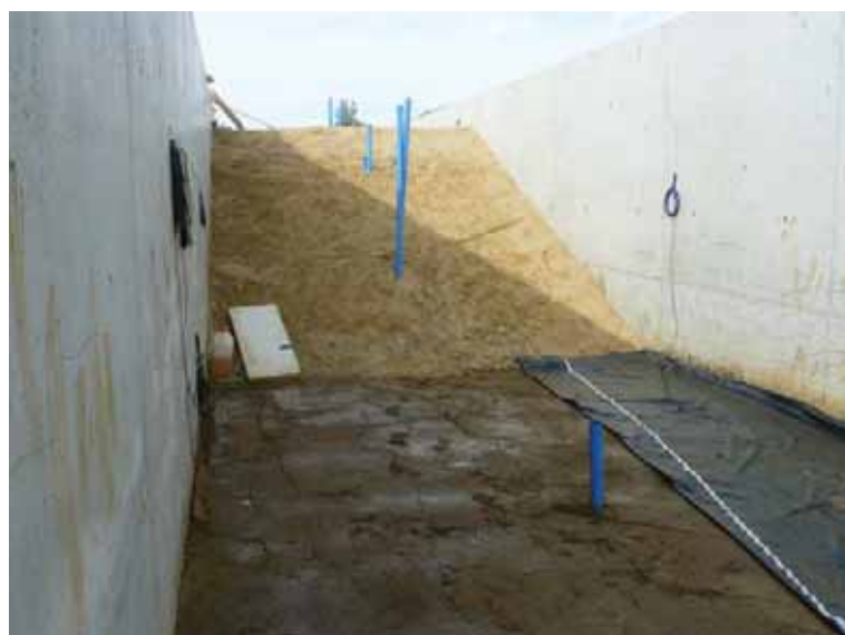
Abb. 3.36: Fertiggestellter Modelldamm.
