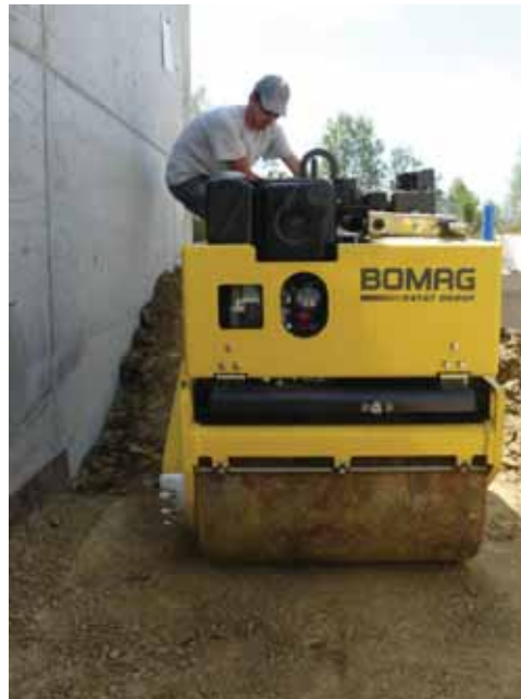
Abb. 3.30: Verdichtung der Deckschicht mittels Doppelvibrationswalze der Firma Bomag.
