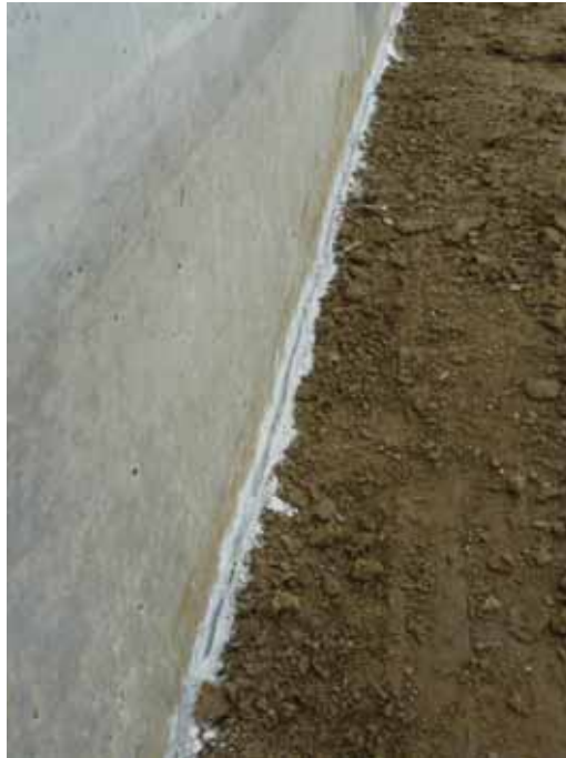
Abb. 3.31: Abdichtung der Randbereiche der Deckschicht mit Bentonit.
