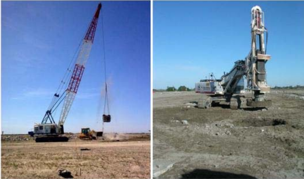
Abb. 18: Kombiniertes Verdichtungsverfahren mit DYNIV und Impulsverdichtung bei der Erweiterung eines Containerterminals in Marseille (Südfrankreich) [23] (links) Raupenkrane mit 15 m Fallhöhe für DYNIV (rechts) Impulsverdichter mit Verdichtungsfuß mit 2,0 m Durchmesser
