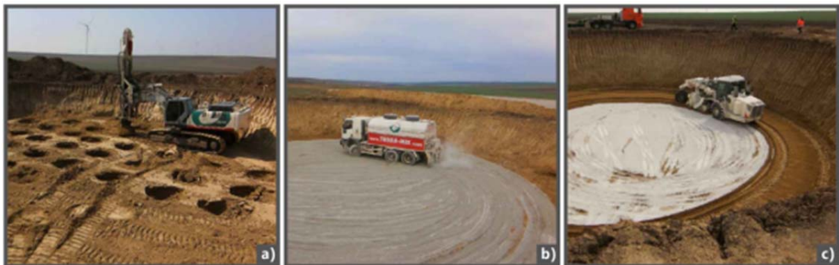
Abb. 17: Bodenverbesserung mit Impulsverdichtung in Kombination mit Bodenstabilisierung für die Gründung einer Windkraftanlage in Tortoman, Rumänien [46]
