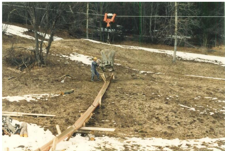
Abbildung 40: Schutzprojekt Unternberger Sonnseite : Links: Einbau der Drainageleitung und des Sammel-schachts. Rechts: Einbringung des Drainagekieses, der zur Trockenlegung benötigt wird (Quelle: ECKERSTORFER 2015, E-Mail).
