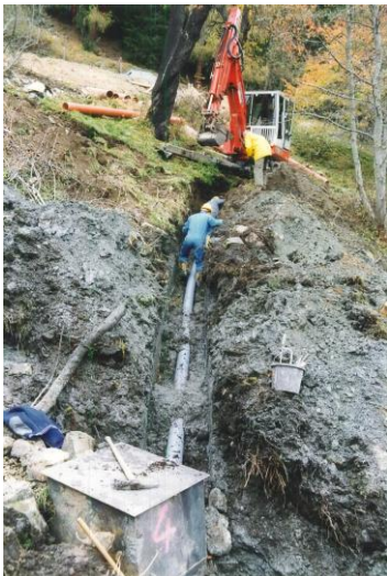
Abbildung 40: Schutzprojekt Unternberger Sonnseite : Links: Einbau der Drainageleitung und des Sammel-schachts. Rechts: Einbringung des Drainagekieses, der zur Trockenlegung benötigt wird (Quelle: ECKERSTORFER 2015, E-Mail).
