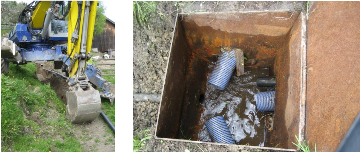
Abbildung 41: Schutzprojekt Unternerger Sonnseite : Links: Grabungsarbeiten für die Ableitung. Rechts: Sammelschacht des Drainagesystems (Quelle: ECKERSTORFER 2015, E-Mail).
