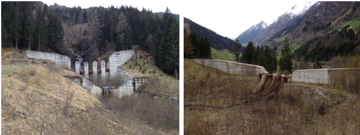
Abbildung 49: Murbrecher Kocher- und Watschergraben (Quelle: Eigene Fotos, 2015).
