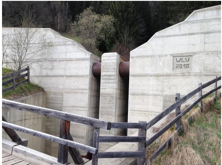
Abbildung 29: Wildbachsperre in Unternberg (Quelle: Eigenes Foto, 2015).
