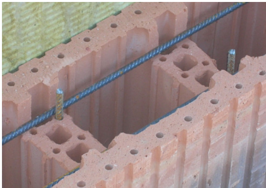
Abb. 3.8: Einbau der vertikalen und horizontalen Bewehrung (Quelle: [28])
