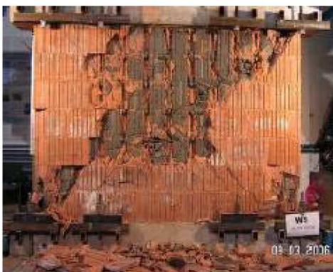
(a) Prüfwand 17-5 (Quelle: [6])
