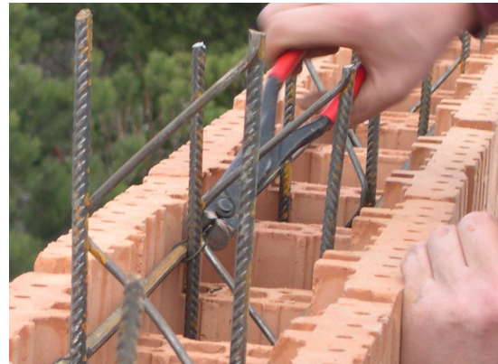
Abb. 3.8: Einbau der vertikalen und horizontalen Bewehrung (Quelle: [28])
