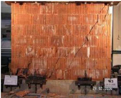
(a) Prüfwand 17-3 (Quelle: [6])
