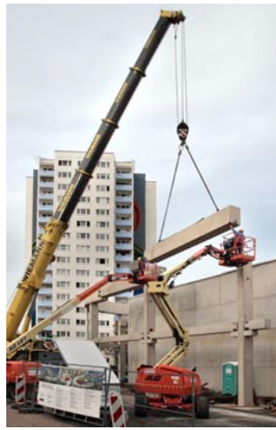
106.1-4 Aufstellung der Stahlbetonkonstruktion für das Wandbild am Moskauer Platz und Transport der Wandbildelemente nach Erfurt, Oktober 2019
