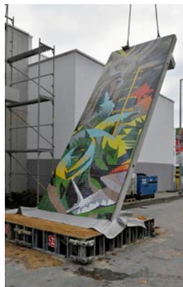
40.4–5 Mittels eines Krans werden die Betonsegmente angehoben und platziert, Oktober 2019
