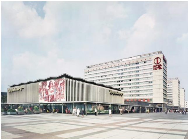
82.1 Dresden, Prager Straße, Selbstbedienungsgaststätte Bastei, 1975
