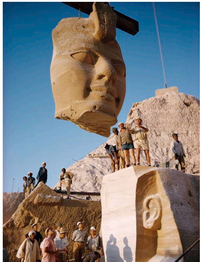
115.1 Die ägyptischen Tempel von Abu Simbel werden zersägt, um sie an einen anderen Ort zu translozieren, Aufnahme Mai 1966.
