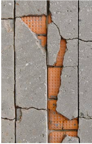
105.1–3 Rückseite des Mosaiks nach Abnahme und Reinigung der ersten Mörtelschicht; Füllen und Reinigung der Rückseite des Mosaiks in der Restaurierungswerkstatt Gustav van Treeck – Werkstätten für Mosaik und Glasmalerei, Unterkammlach, Unterallgäu, Frühjahr 2019
