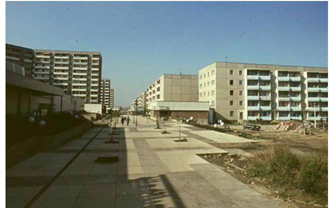
15.2 Wohngebiet Berliner Platz, Fußgängerzone als Verbindung zum Moskauer Platz, Fotografie von Renau, ca. 1976
