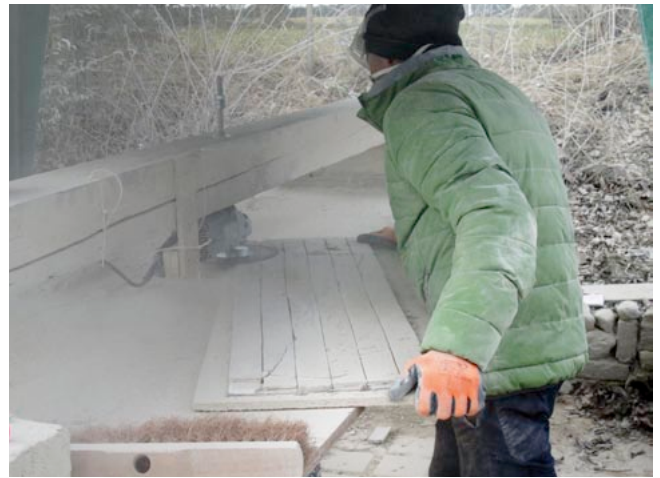
109.2 Abschneiden und Abschleifen des Ausgleichsmörtels auf der Wandbildrückseite, Unterkammlach, Frühjahr 2019
