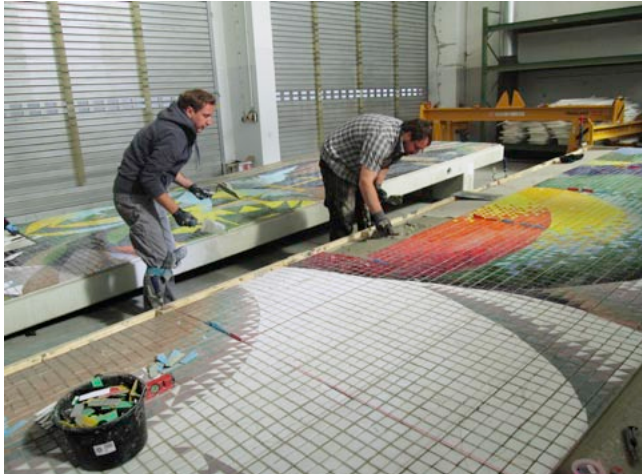
113.1 Aufmörteln der Mosaikfelder in der Montagehalle, Tautenhain, Sommer 2019
