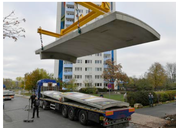
40.4–5 Mittels eines Krans werden die Betonsegmente angehoben und platziert, Oktober 2019
