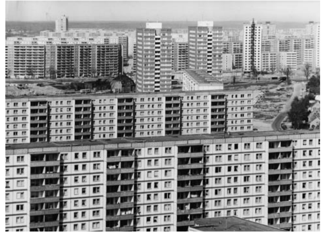
97.2 Gebäude der Wohnbauserie „WBS 70“ in Berlin-Marzahn, 1984
