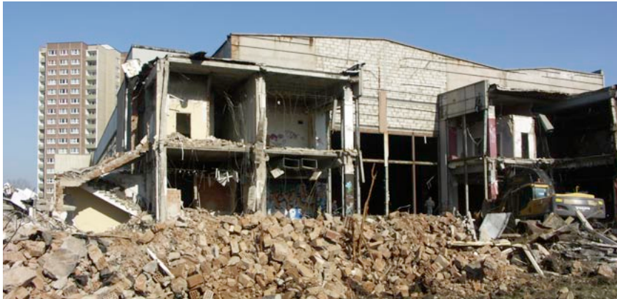
33.1 Schrittweiser Abriss des Kultur- und Freizeitentrums ab 2009
