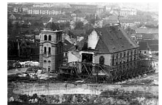
115.3 Die Dekanatskirche mit abgebrochenem Frontturm wird für die Translozierung bereitgestellt, Aufnahme 1970.
