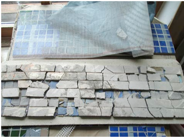
109.1 Rückseite des Wandbildes vor dem Abschneiden des Ausgleichsmörtels, Unterkammlach, Frühjahr 2019
