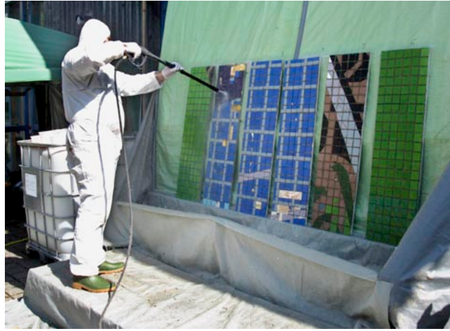
110.2 Ablösung der Kaschierung auf der Wandbildvorderseite mittels Heißwasser, Unterkammlach, Frühjahr 2019
