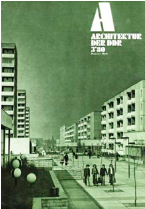
12.1 Wohngebiet Erfurt-Nord, Fußgängerzone Berliner Platz, Cover Architektur der DDR , 3/1980
