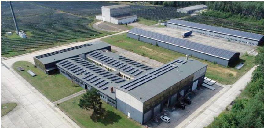
37.1 Halle in Tautenhain, in der die Wandbildmontage stattfand
