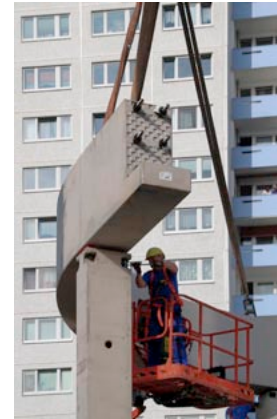
40.2–3 Stahlbetonkonstruktion für das Wandbild am Moskauer Platz, Herbst 2019
