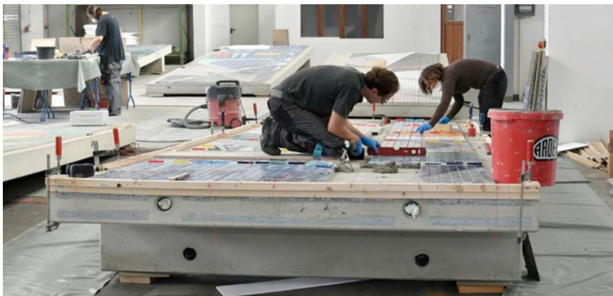
37.2 Mittels eines Fasermörtels wurden das Mosaik auf die Betonschalen aufgebracht
