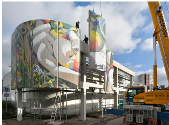
40.6–7 Einhängen und Ausrichten der Elemente in die Stahlbetonkonstruktion, Oktober 2019
