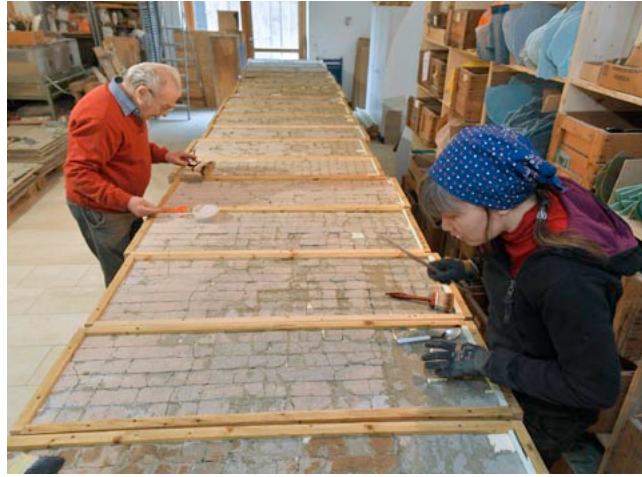
105.1–3 Rückseite des Mosaiks nach Abnahme und Reinigung der ersten Mörtelschicht; Füllen und Reinigung der Rückseite des Mosaiks in der Restaurierungswerkstatt Gustav van Treeck – Werkstätten für Mosaik und Glasmalerei, Unterkammlach, Unterallgäu, Frühjahr 2019
