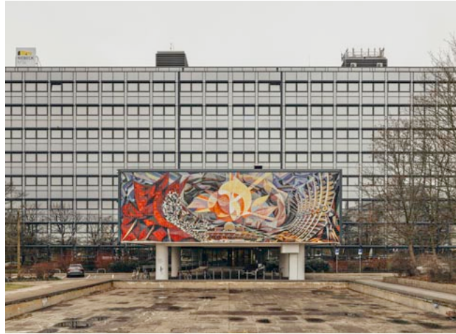
84.4 Josep Renau, Wandbild Eingangsgebäude vor veränderter Fassade, 2017
