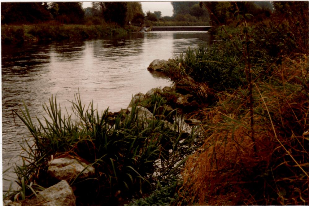
Abb. 8: Uferanriss mit vorgelagerter Reihe aus Blocksteinen, die ehemals zur Ufersicherung angeschüttet worden waren; in den Bereichen relativ geringer Wasserbewegung kann sich ein Röhrichtstreifen ausbilden (nähere Erläuterungen im Text). Im Hintergrund ein Wehr mit Steilabsturz.
