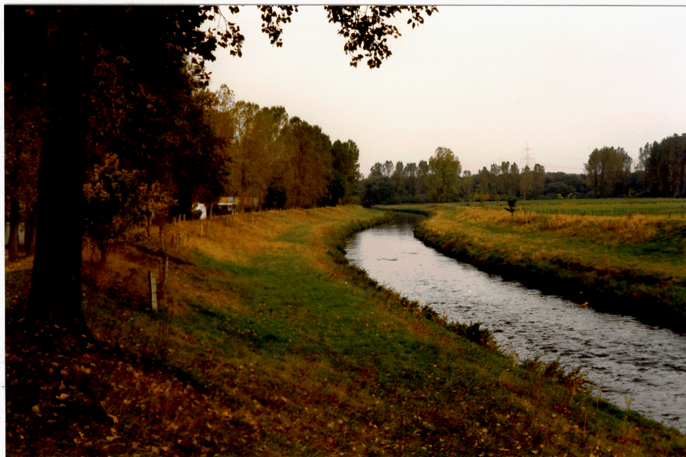
Abb. 5: Regulierter Unterlauf der Inde bei Kirchberg (Abschnitt 51). Durch die beidseitigen Deiche gegen Winterhochwässer entsteht ein Doppelprofil; zwischen den Deichen werden keinerlei Gehölze geduldet.
