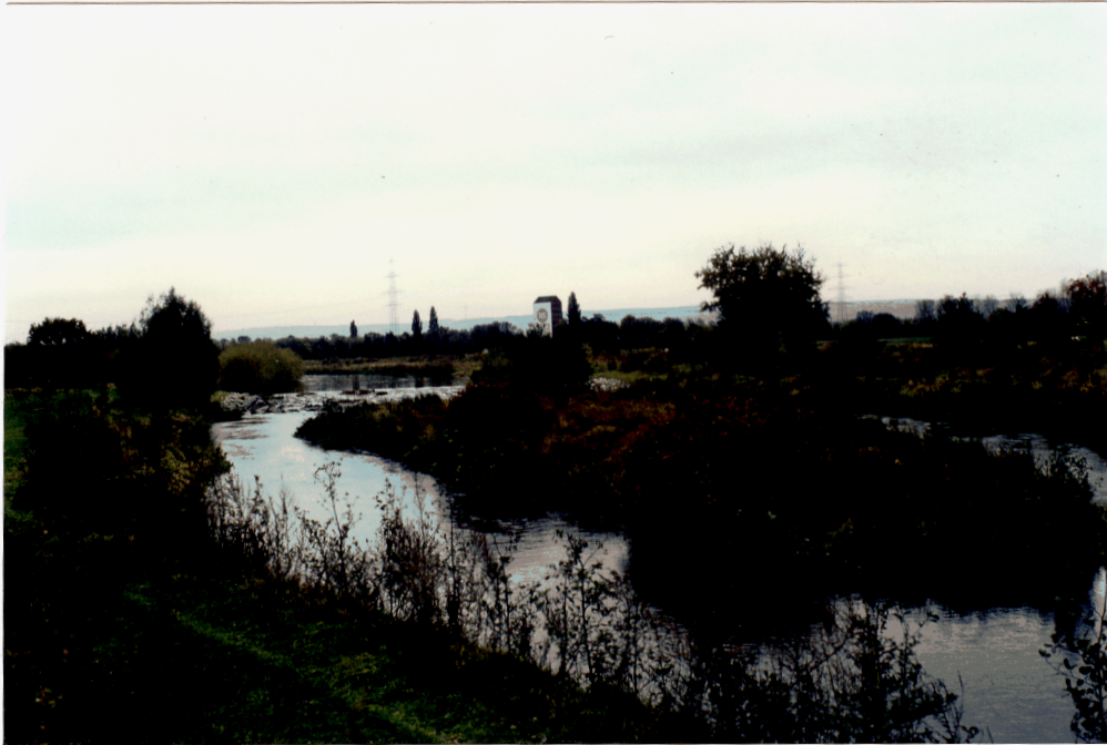
Abb. 7: Insel aus jungen Hochflutsedimenten in der Rur bei Merken (Abschnitt 3). In diesem Bereich brach der Fluß aus dem regulierten Bett aus, drohte die Winterhochwasser-Deiche anzugreifen; er wurde dann unter Erhaltung der Inseln zurückverlegt. Im Hintergrund eine Sohlrampe mit Blocksteinen.
