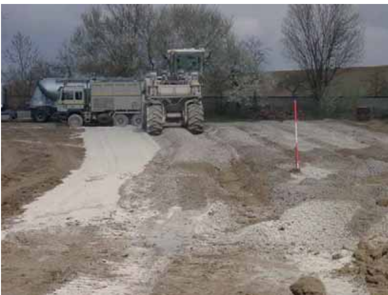
Bodenaufbereitung mit Zement und Weißfeinkalk
