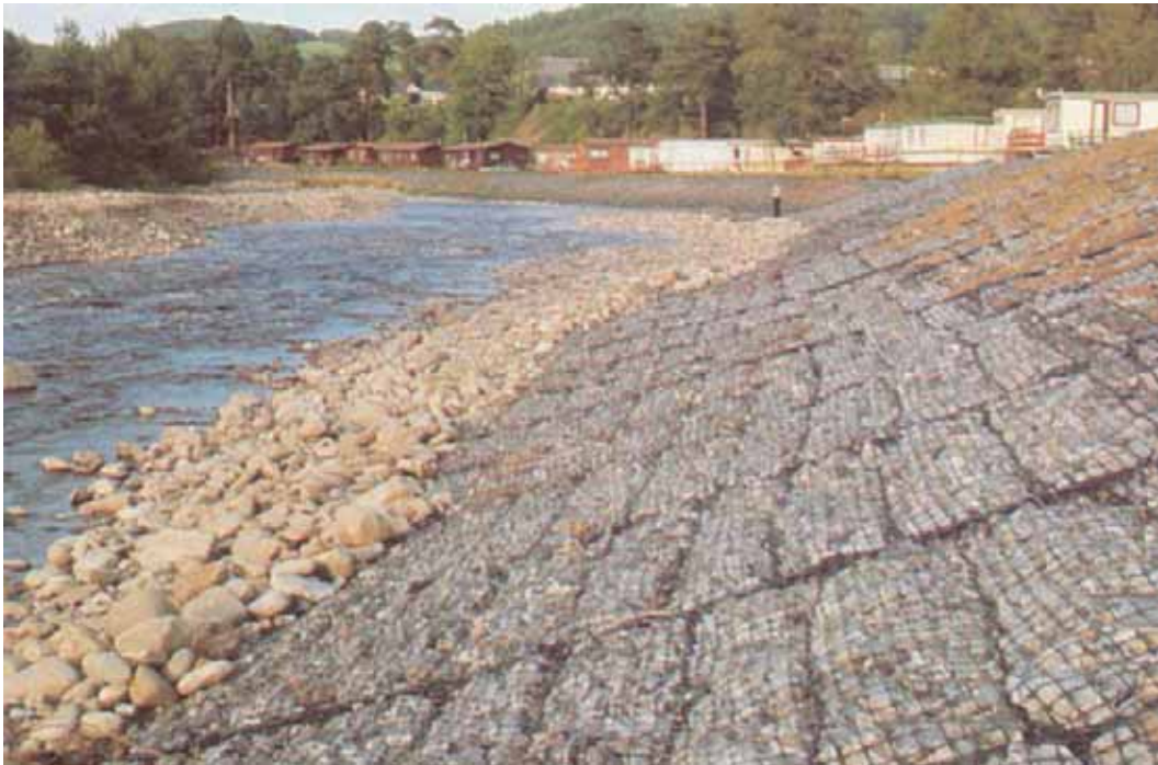
Abbildung 10: Geogittermatratzen als Ufersicherung.
