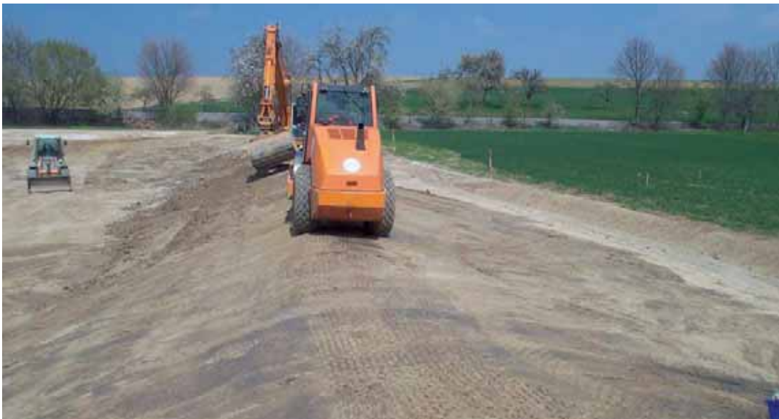
Abbildung 48: Überströmbarer Damm hergestellt durch Bodenverfestigung am RRB Hemmingen.
