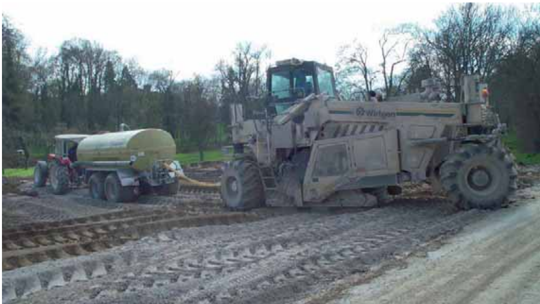
Abbildung 47: Bodenfräse (im Zug mit Wasservorratstank).
