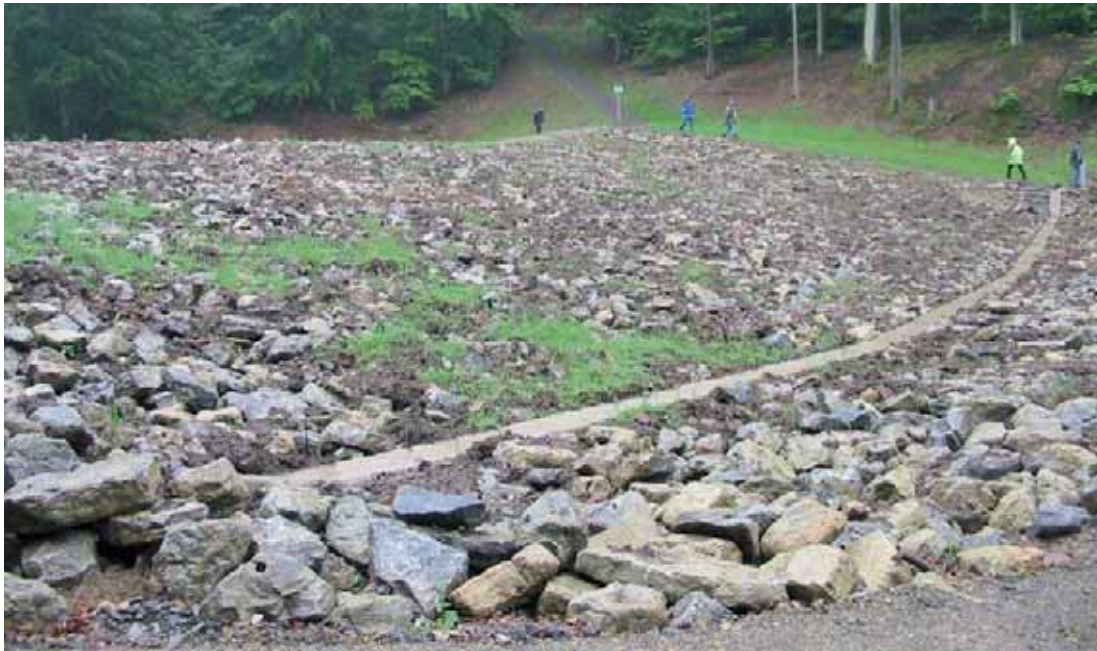
Abbildung 8: Steinschüttung am HRB Haager Tal des Zweckverbands Hochwasserschutz Einzugsbereich Elsenz-Schwarzbach.
