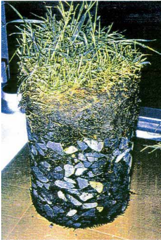
Abbildung 12: Bohrkern aus einem begrünten Mastix-Schotter-Deckwerk (auf Geogewebe).
