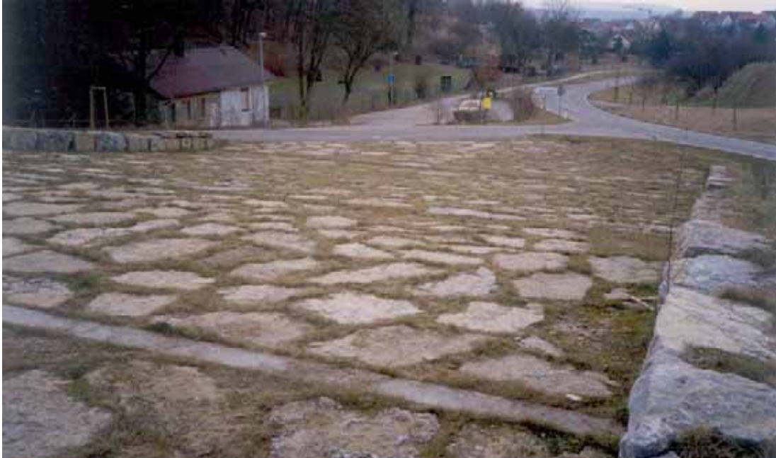
Abbildung 30: Steinsatz mit Querriegeln am HRB Kohlbach.
