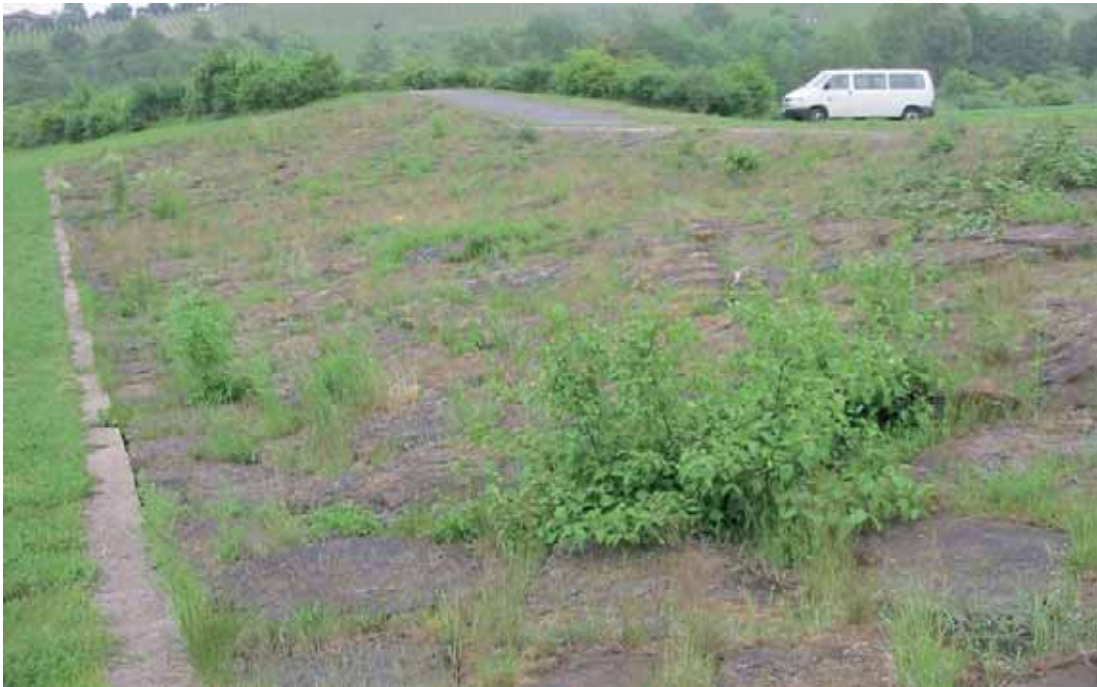
Abbildung 6: Teilweise überströmbarer Dammbereich (Dammscharte) als Steinsatz am HRB Eilbach des Wasserverbands Sulm.
