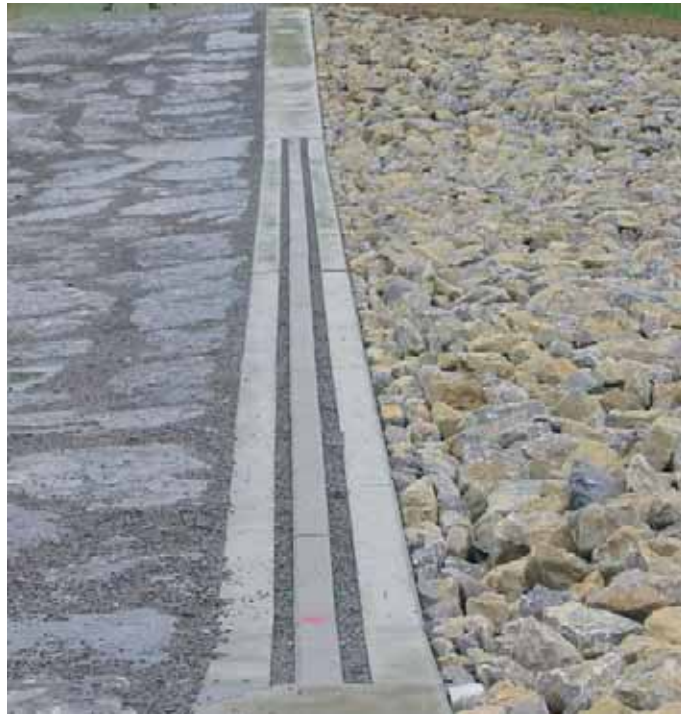
Abbildung 22: Ausführungsbeispiel einer in Betonfundamenten versetzten Überlaufschwelle.
