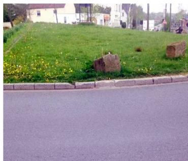
Daher ist eine Umgestaltung des Randbereiches durch ein Abschrägen des Innenbereiches zur Fahrbahn hin u.E. nach sinnvoll, um den immer wieder auftretenden Beschädigungen entgegenzuwirken bzw. diese erheblich zu minimieren.
