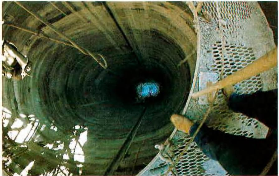
Abb. 7: Der fertig betonierte Schacht
