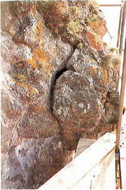
Abb. 3: Loser Felsbrocken in Gerüsthöhe 56 m
