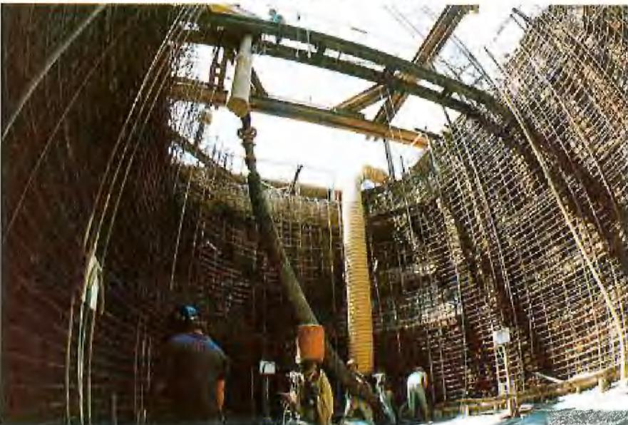
Der Förderschacht, der später mit einem Skip ausgerüstet wird, hat einen lichten Durchmesser von 6,10 m und eine Endteufe von 359 m; der Material- und Seilfahrtschacht hat einen elliptischen Querschnitt mit den lichten Halbachsen von 5,00 m und 3,30 m und eine Endteufe von 327 m.
