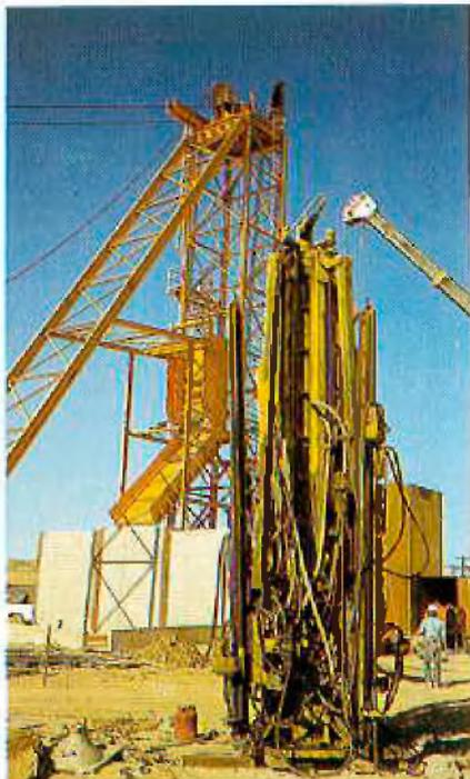
Abb. 10: Schachtturm für den Förderschacht während der Montage und Schachtbohrgerät
