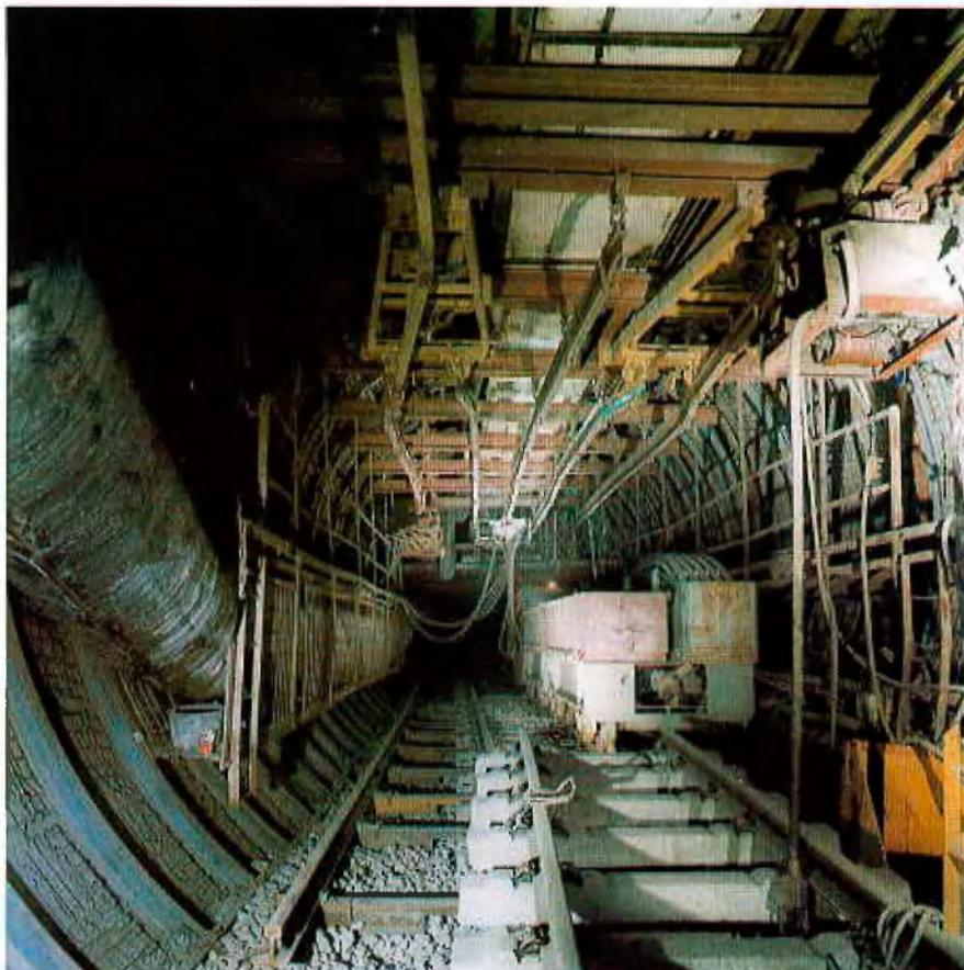
Abb. 3: Materialumschlagstation hinter der Maschine
