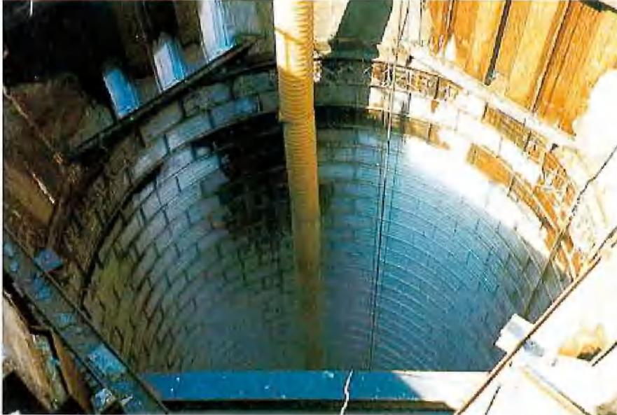
Abb. 4: Blick in den gefrorenen Förderschacht. Die Liner Plates sind vereist.
