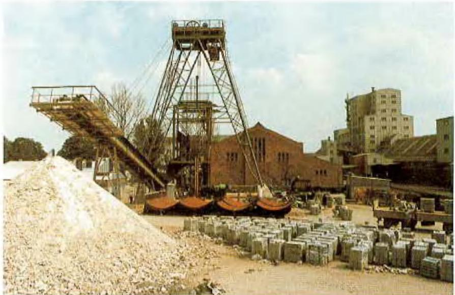
Abb. 1: Schachtplatz mit gelagerten Betonformsteinen und Stahlblechschüssen
