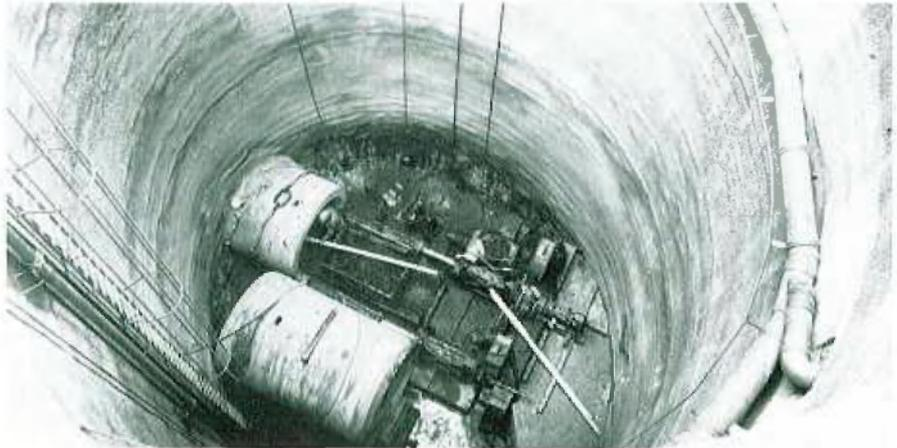
Abb. 1: Preßschacht mit Spritzbetonverbau
