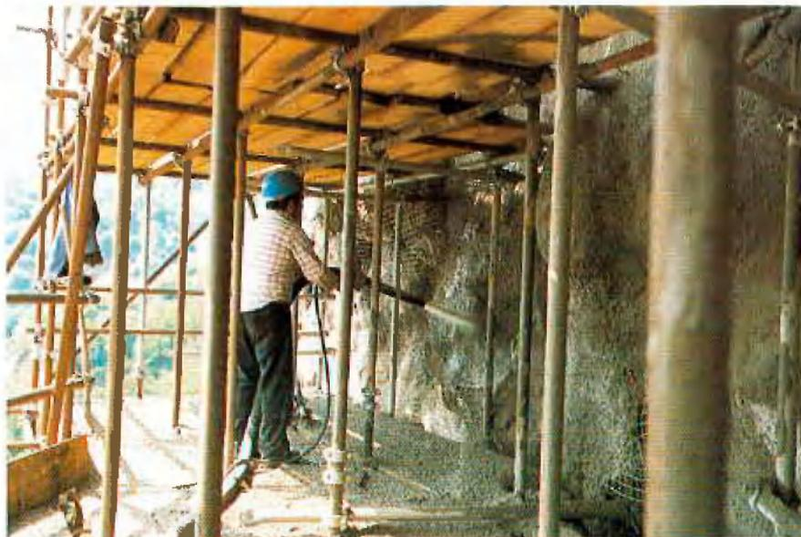
Abb. 6: Aufbringen der Betonschicht
