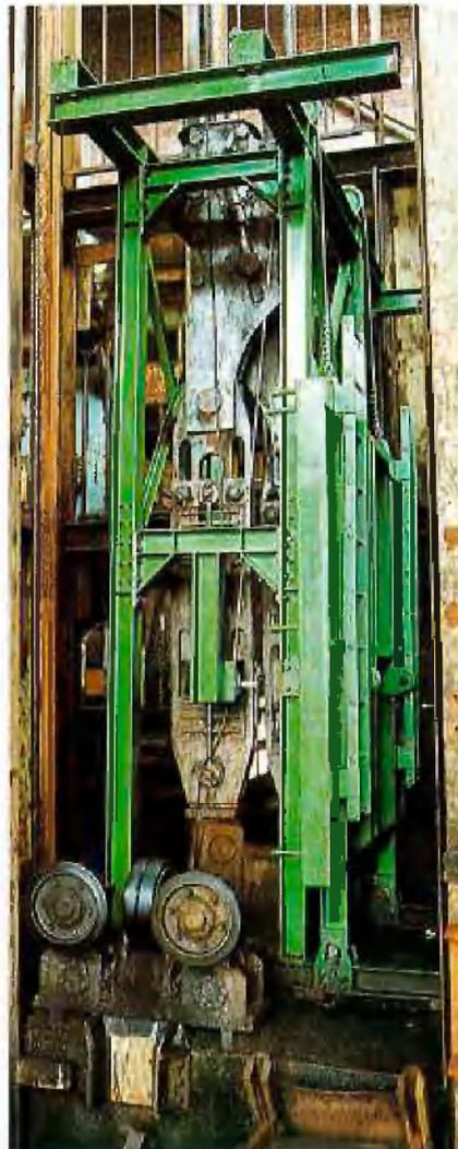
Abb. 1: Westliches Schachtfördertrum mit 5tagiger Spurlatteneinbaubühne; westlicher Strang bereits fest eingebaut, östlicher Strang noch frei hängend im Schacht
