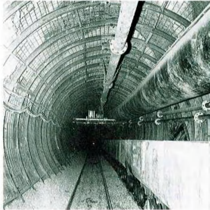
Die Robbins-Streckenvortriebsmaschine bohrt Gesteinstrecken, hier mit einem Durchmesser von 4,80 m
