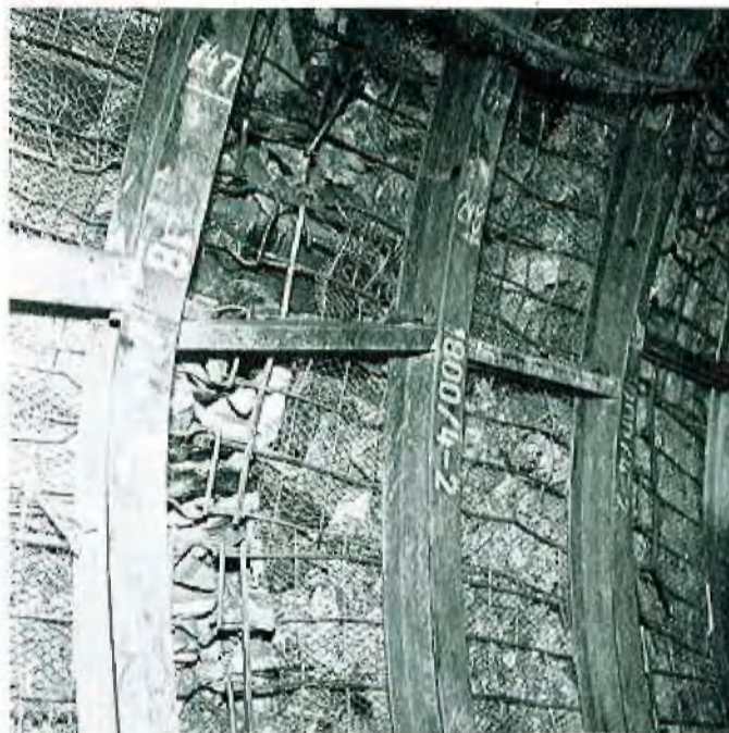
Streckenabschnitt im Quintus, Bauabstand 0,55 m: Das Gebirge ist infolge intensiver Faltung und Durchklüftung stark nachbrüchig
