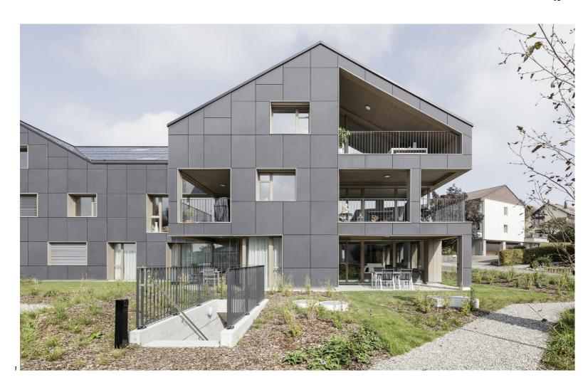
1\_Auf den ersten Blick täuscht die matt anthrazitfarbene Fassade: Es sind keine einfachen Glaspaneele; sie produzieren Solarstrom. La façade anthracite mate est à première vue trompeuse: au lieu de simples panneaux vitrés, il s'agit en fait de cellules photovoltaïques. A prima vista la facciata opaca color antracite potrebbe ingannare: non si tratta di semplici pannelli di vetro, ma di moduli fotovoltaici. **2\_** Anlagenschema. Schéma de l'installation. Schema degli impianti.
