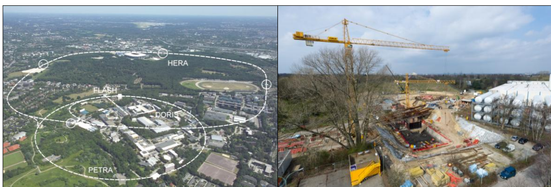
Abbildung 1: Gelände des Hamburger Standortes von DESY (links) und die dortige European-XFEL-Baustelle am 04. April 2011 (rechts) 2
