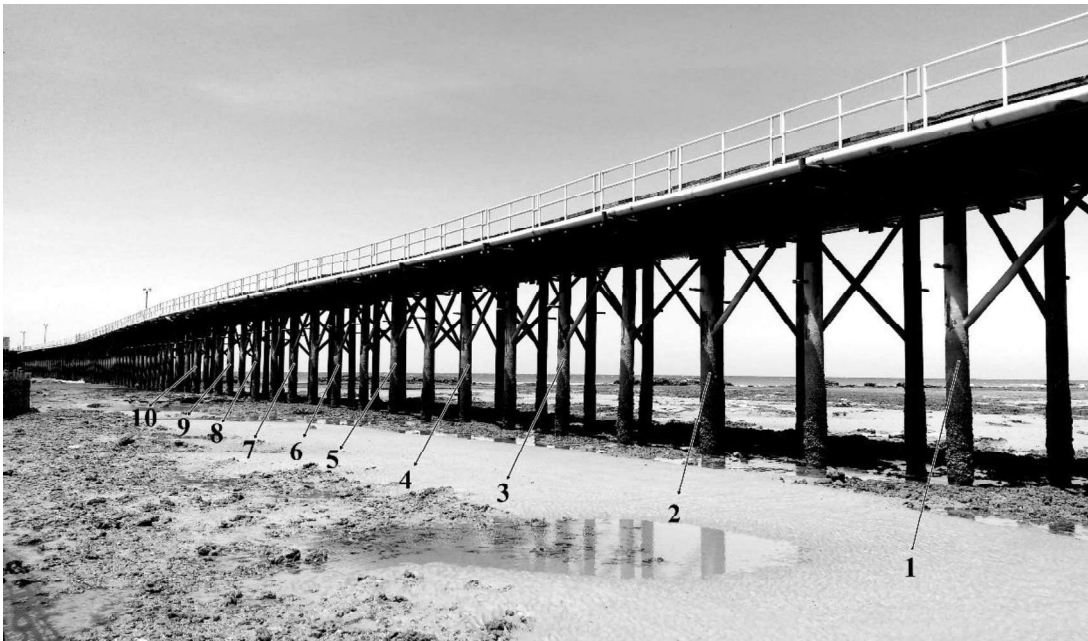
Figura 2: Pilares do píer na praia de Pedra Rachada no município de Paracuru, oeste do Ceará, Brasil. Cinco destes pilares eram sorteados a cada amostragem mensal.
