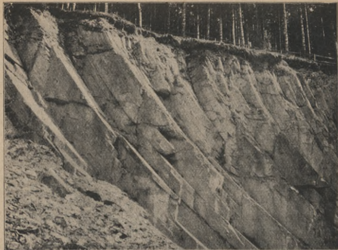
Abb. 12. Der Plattensteinbruch im Quarzporphyr des Hochberges bei Gottesberg in Schlefien. Auffallend regelmäßige und dünnplattige Absonderung des Porphyrs.
