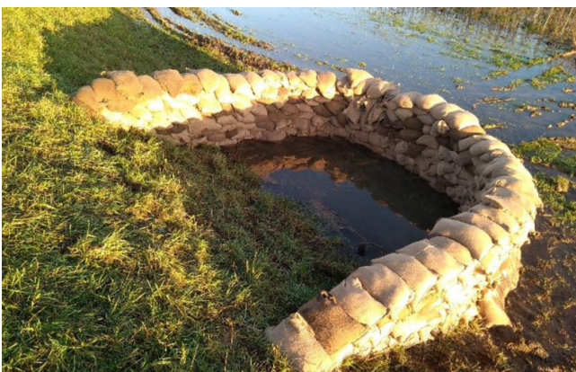
Abb. 40 Einzelne Quellkade an einer lokalen Austrittsstelle [RPDA]
