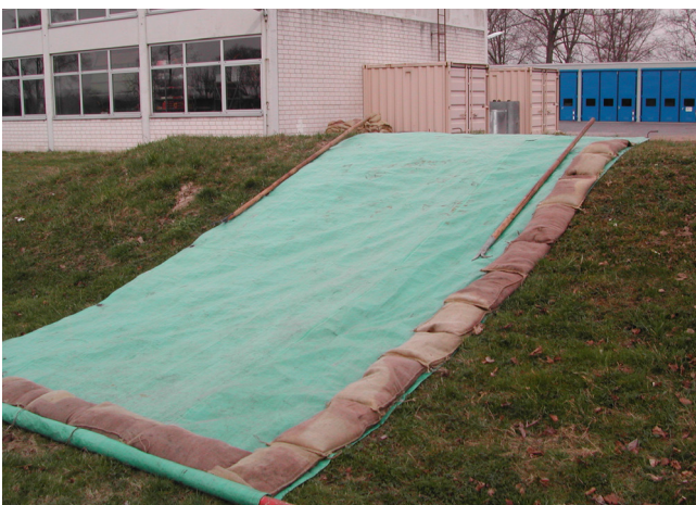
Abb. 51 Lecksegel bei Übung an der Deichmeisterei [RPDA]
