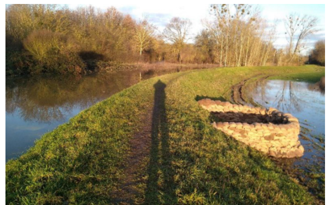
Abb. 41 Einzelne Quellkade an einer lokalen Austrittsstelle [RPDA]
