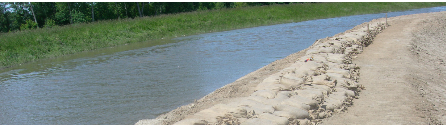
Abb. 59 Deicherhöhung aus Sandsäcken an der Weschnitz 2013 [RPDA]
