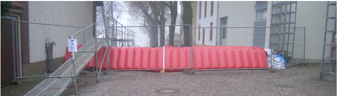
Abb. 64 verschiedene Mobile Systeme (Dammbalken, Schlauchsystem) im Einsatz beim Mainhochwasser 2011 [RPDA]
