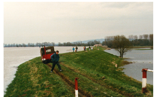
Abb. 66 Das Befahren oder Begehen der Deiche und deren Böschungen führt schnell zu einer Schwächung der Standsicherheit und sollte vermieden werden. [RPDA]
