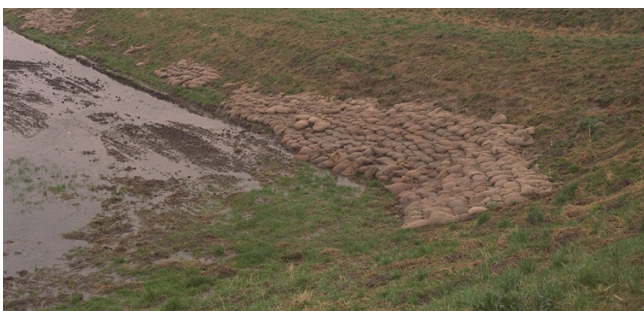
Abb. 45 Sandsackauflast zur Sicherung des landseitigen Böschungsfußes [RPDA]
