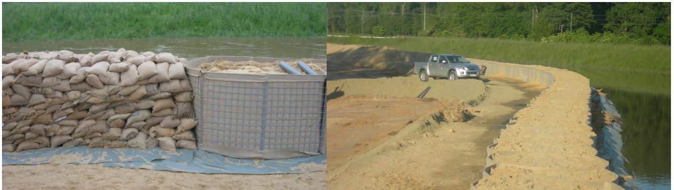
Abb. 63 Mobiles System (Körbe) an der Weschnitz 2013 [RPDA]
