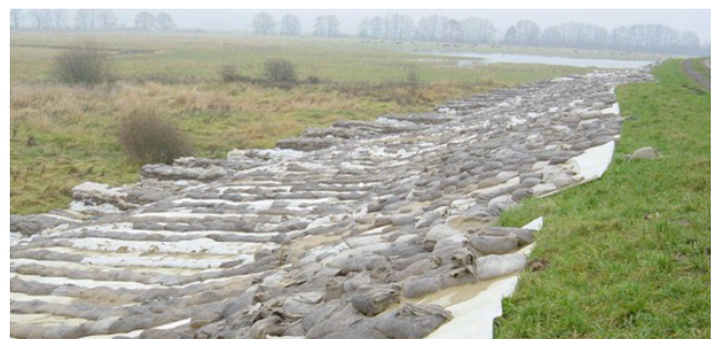
Abb. 46 Stützung der landseitigen Böschung durch Filtermatte mit Sandsackauflast (Auflastfilter) [RPDA]
