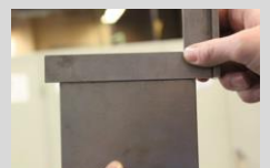
Ebenheit mit Augenmaß und Anschlagwinkel prüfen
