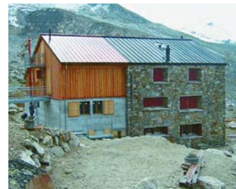
Im Juni 2007 beginnt die Sanierung der Westfassade.
