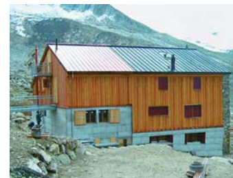
So präsentiert sich die Westfassade nach Abschluss der Arbeiten. (Fotomontage)
