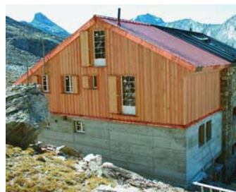
Die Nordfassade wird noch mit einem Notsteg ergänzt.
