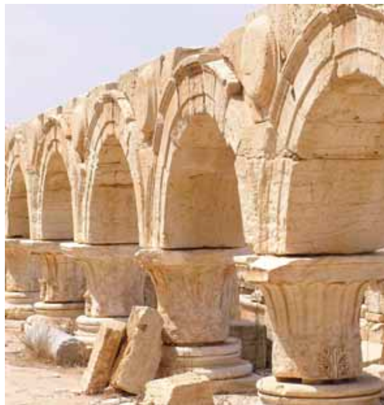
Lepcis Magna. Porticul forului nou, înainte de restaurare.
