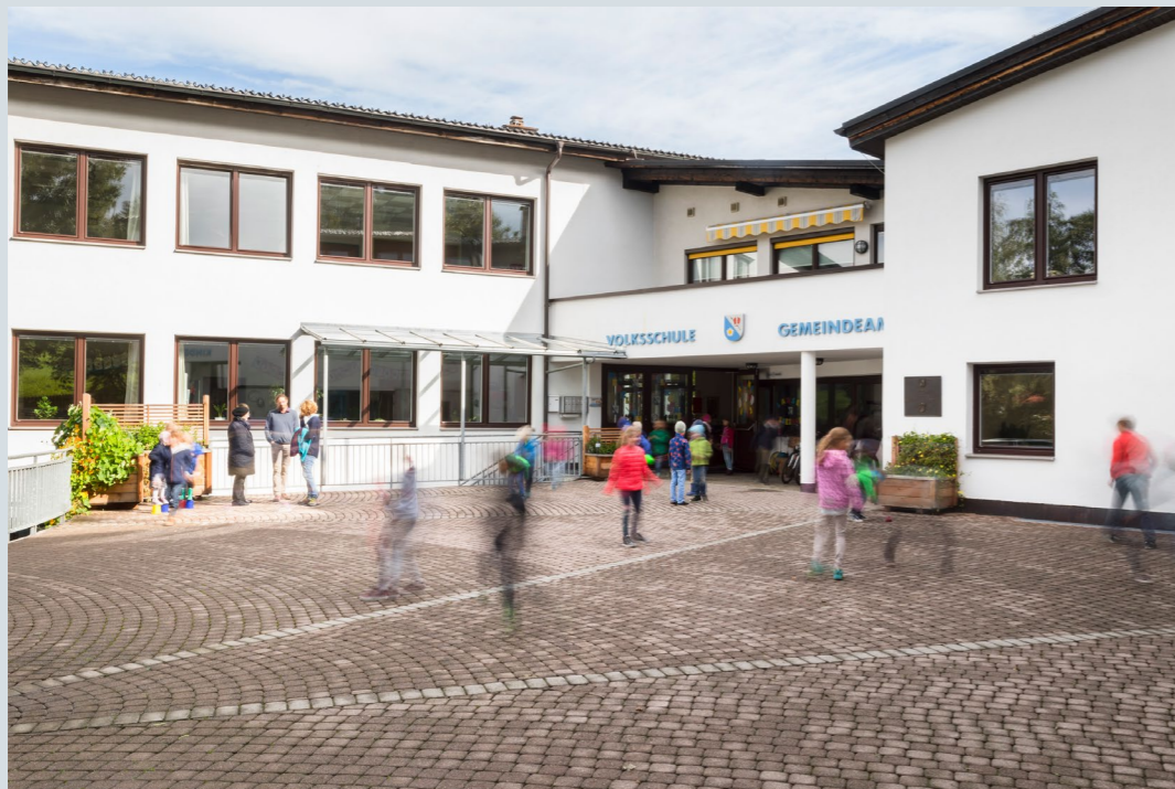
Das bestehende Schulgebäude am Scheibeweg aus dem Jahr 1965
