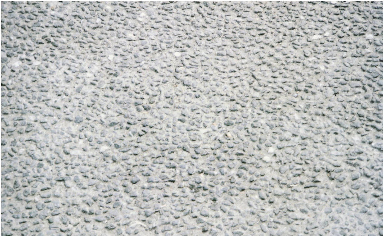
Abb. 7.5.6: Waschbetonoberfläche erstellt durch Ausbürsten der nicht angebondenen Bestandteile.
