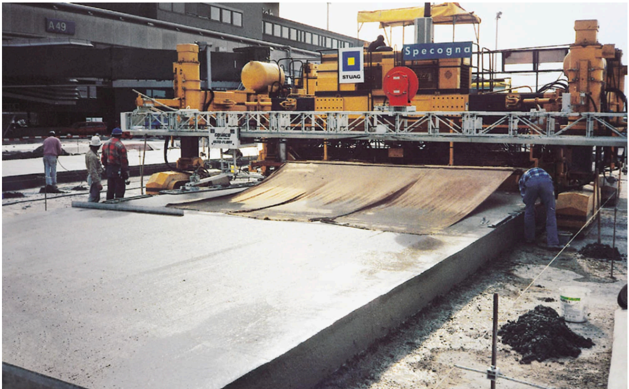
Abb. 7.5.5: Abziehen der Oberfläche mit dem Jutetuch.
