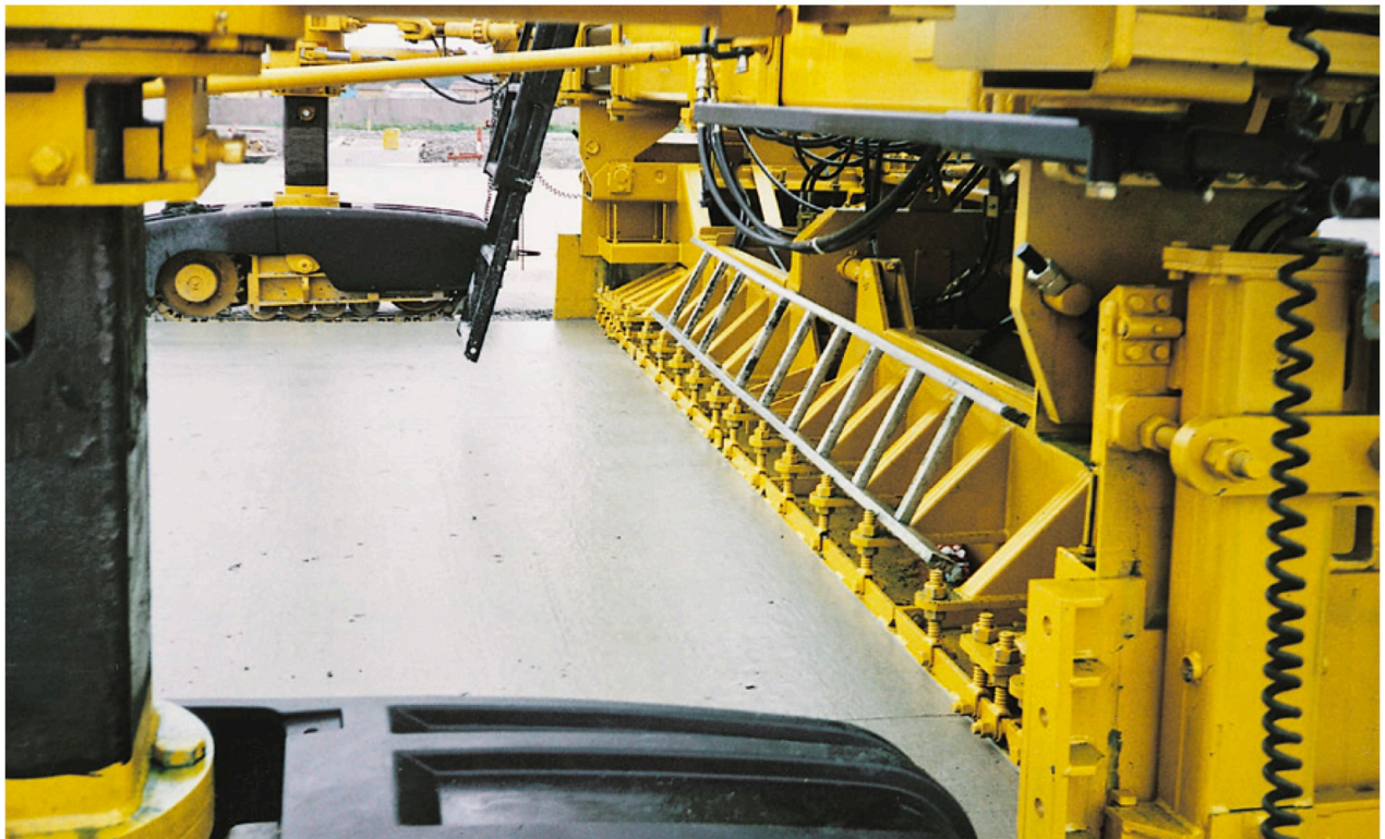
Abb. 7.5.2: Stehende Kante bei Beton mit hoher Grünstandsfestigkeit (oben), geschlossene Oberfläche
