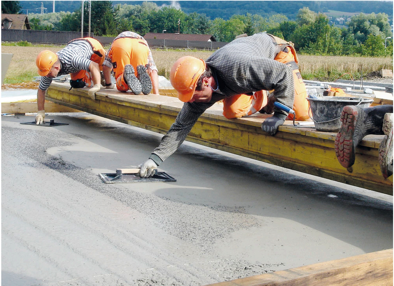
Abb. 7.5.3: Händische Oberflächenbearbeitung einer Betondecke.
